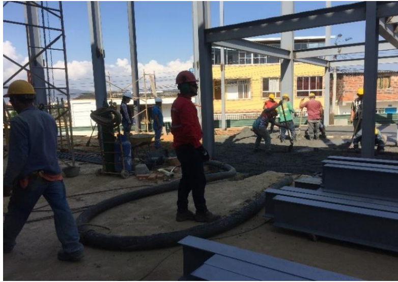
Imagen 7 Fundida de la primera placa con bomba
