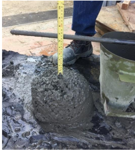
Imagen 8 Prueba de slump al concreto de placa entre 6" y 7"
