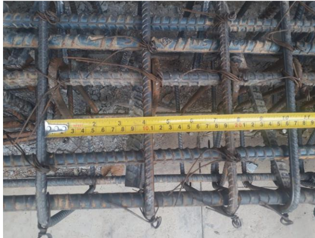
Imagen 27 Chequeo de espacio entre estribos viga de amarre
