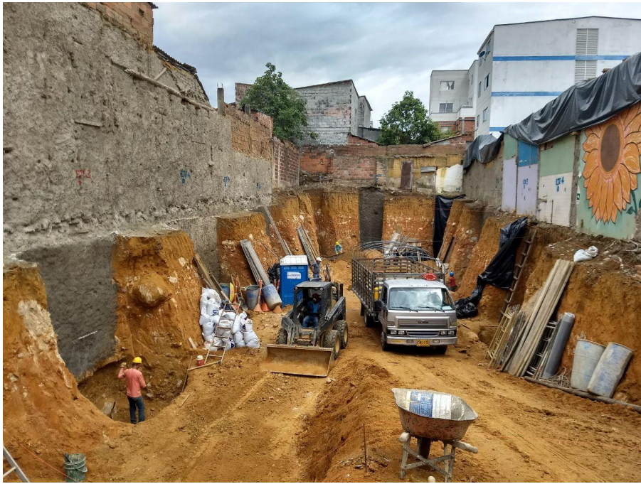
Imagen 20 Taludes cubiertos con plástico
