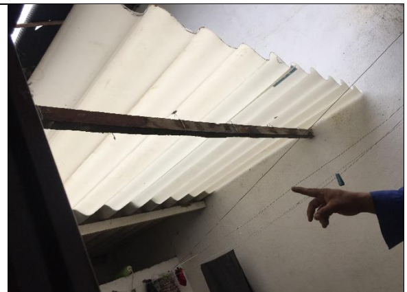
Imagen 17 Arreglo realizado y recibido por el dueño de la vivienda
