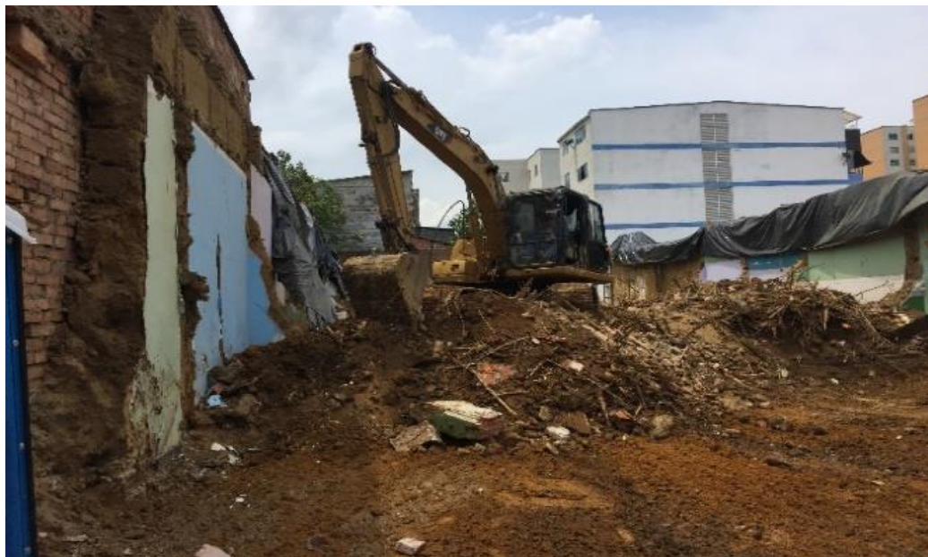
Imagen 13 Supervisión de obra en etapa de demolición.
