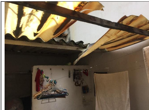
Imagen 16 Problemas presentados con los vecinos de la obra
