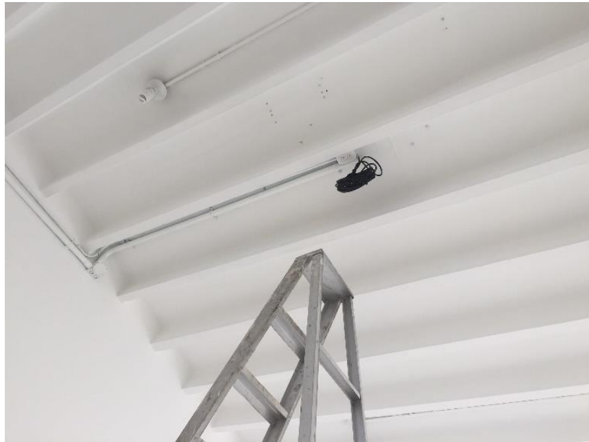
Imagen 12 Detalles de pintura y elementos de electricidad
