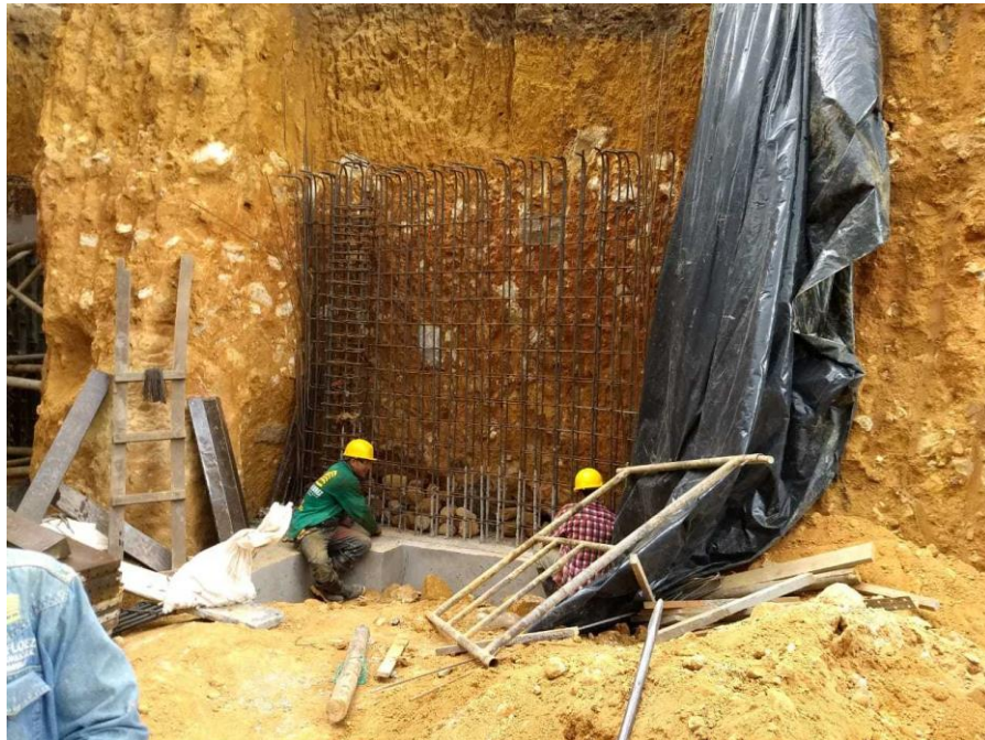
Imagen 33 Construcción de muro de contención
