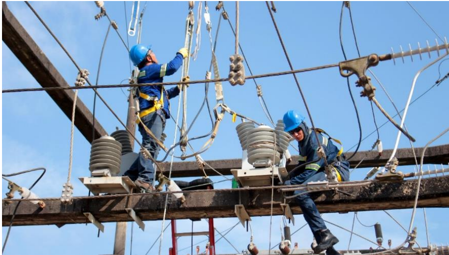
Figura 18. Desmontaje de transformadores de potencia y tensión viejos.
