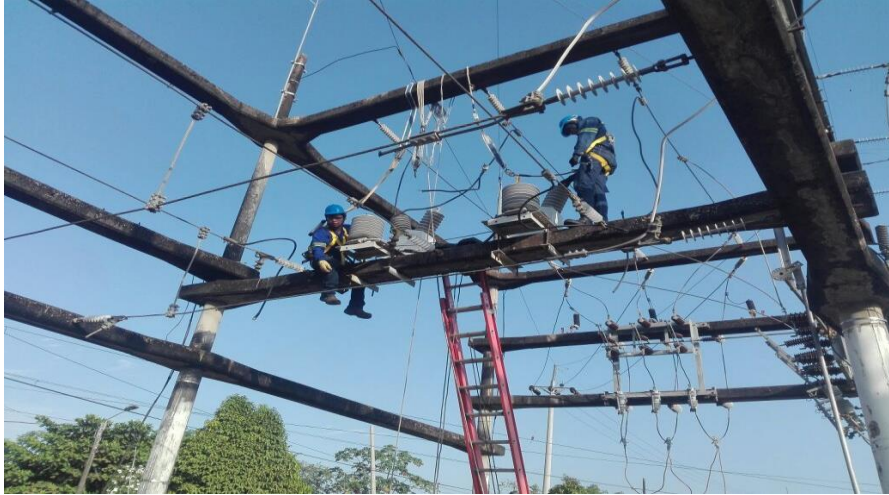
Figura 19. Instalación y conexión de elementos transformadores. Fuente: Tomada directamente en la Empresa Aguas de Barrancabermeja S.A.E.S.P.
