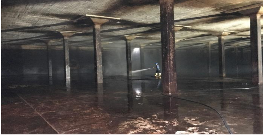
Figura 23. Lavado de tanque enterrado número 1 o "viejo". Fuente: Tomada directamente en la Empresa Aguas de Barrancabermeja S.A.E.S.P.
