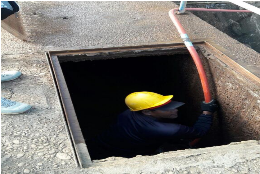
Figura 26. Lavado de canal de unificación.
