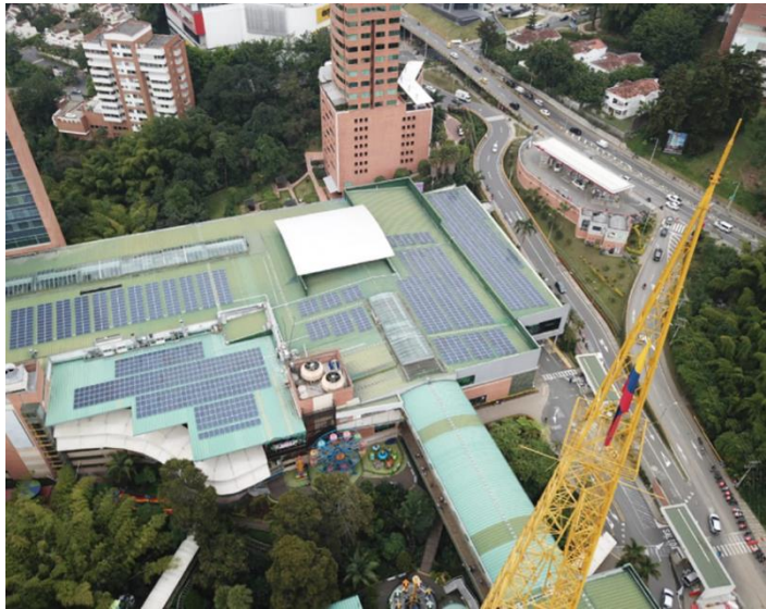
Figura 11. Vista aérea. Imagen tomada de: Erco, energía.
