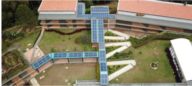
Figura 12. Vista aérea. Imagen tomada de: Erco, energía. .
