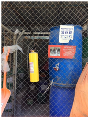
Ilustración 26. Almacenamiento residuos peligrosos
