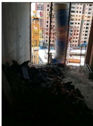
Ilustración 24. Disposición de escombros en el lugar
