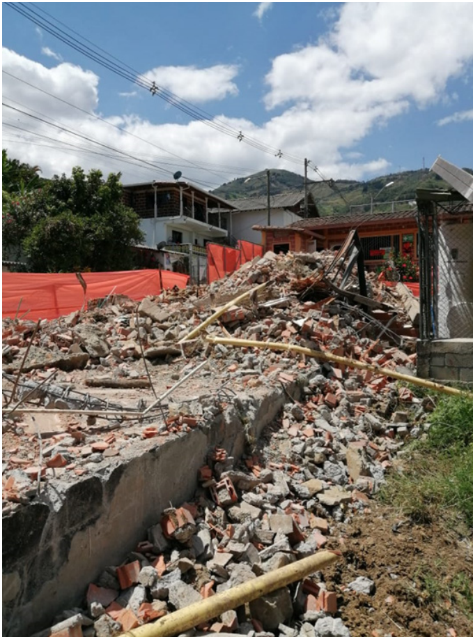
Ilustración 11. Residuos de demolición Fuente: Ingeniera ambiental obra La Aldea
