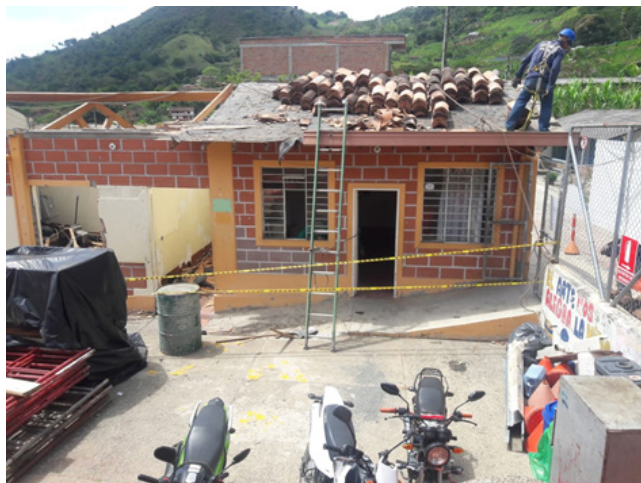
Ilustración 13. Desmonte tejas de barro Fuente: Ingeniera ambiental obra La Aldea
