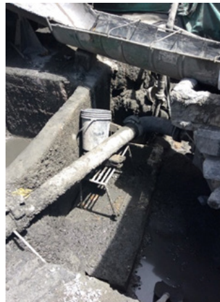
Ilustración 46. Bomba de concreto
