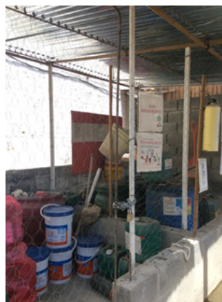
Ilustración 52. Almacenamiento residuos peligrosos
