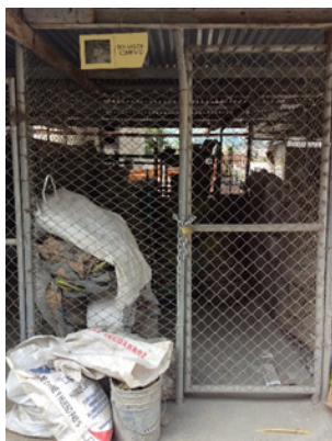
Ilustración 29. Almacenamiento bolsas cemento
