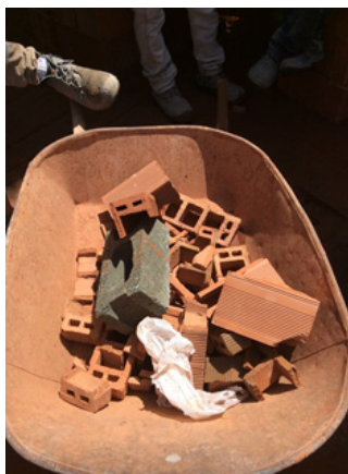
Ilustración 43. Escombros de mampostería por cortadora
