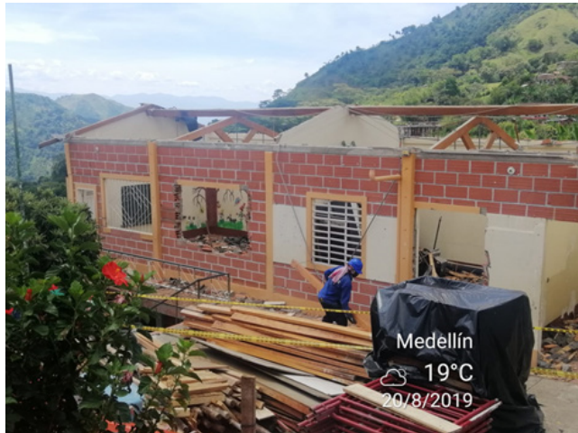
Ilustración 12. Desmonte largueros Fuente: Ingeniera ambiental obra La Aldea
