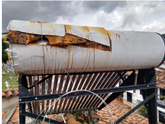
Figura 16. Desmontaje calentador solar de agua de tubos al vacío
