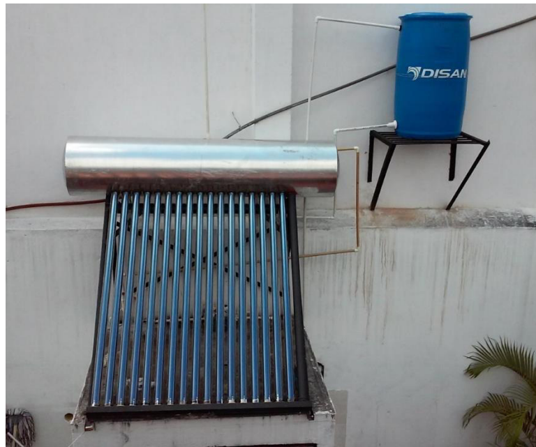
Figura 35. Instalación final del calentador solar de agua de tubos al vacío.
