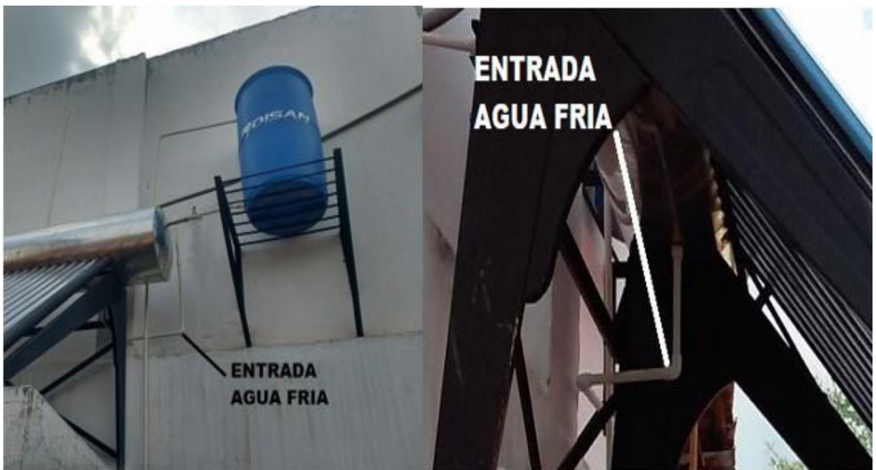
Figura 33. Conexiones agua fría.
