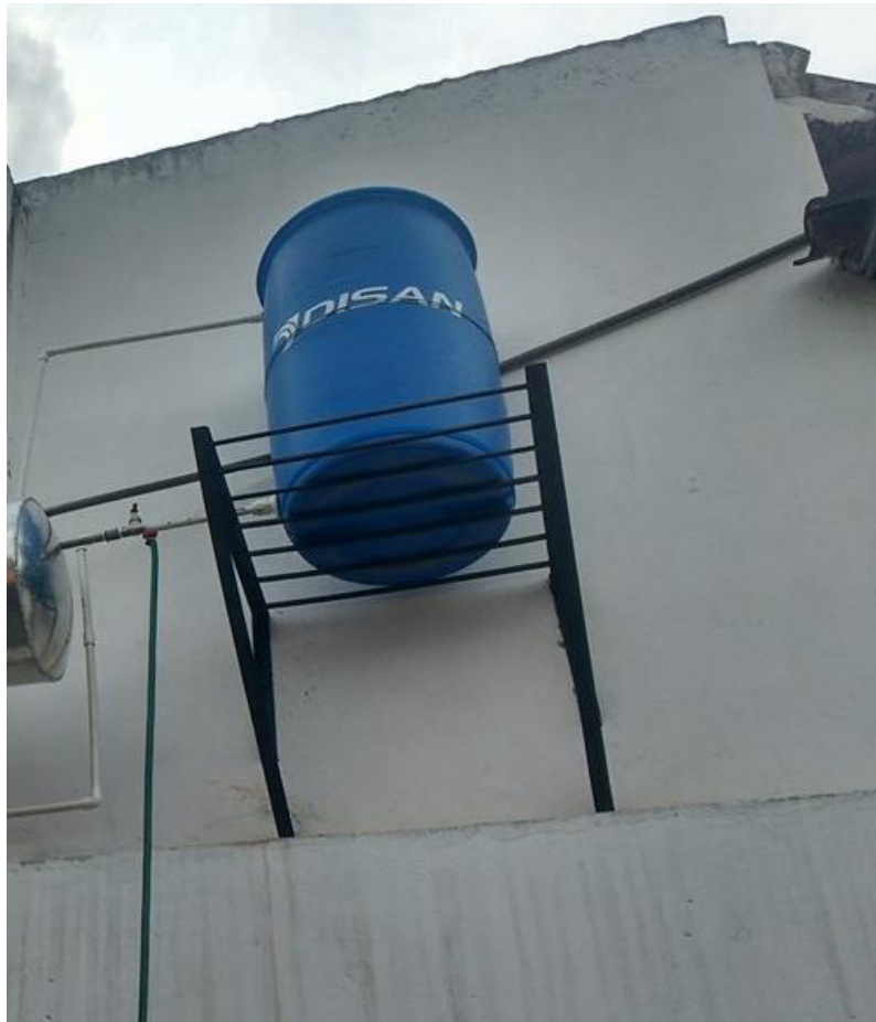
Figura 32. Instalación tanque externo y base de soporte.
