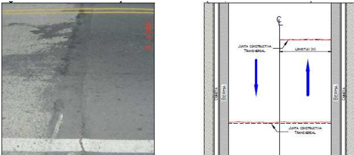
Figura 5-Fisura Transversal en Junta de Construcción
