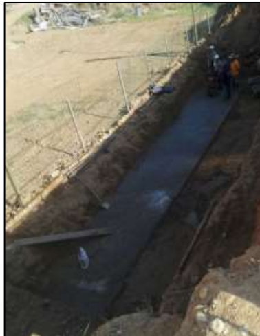
Imagen 4. Nivelación de piso.
