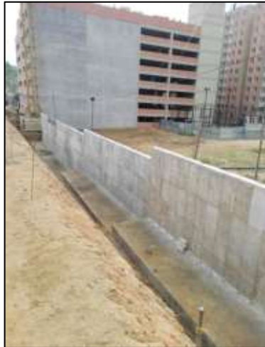
Imagen 8. Desencofrado zapata y muro.
