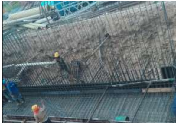
Imagen 5. Instalación acero refuerzo.
