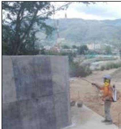
Imagen 9. Aplicación Antisol.
