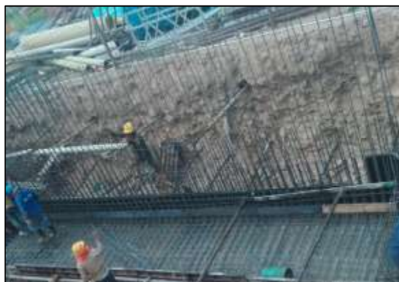
Imagen 6. Instalación acero refuerzo.
