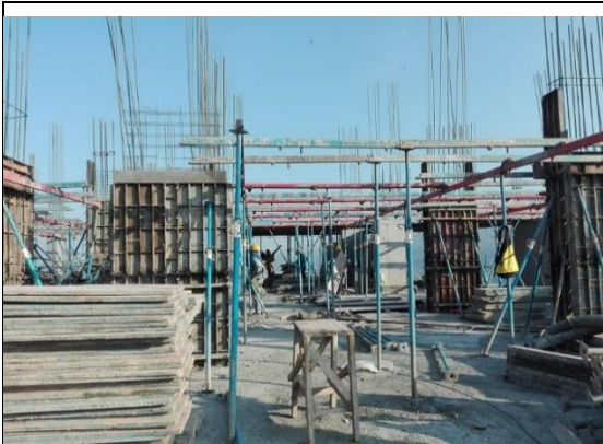
Figura 12. Armado de parales y cerchas
