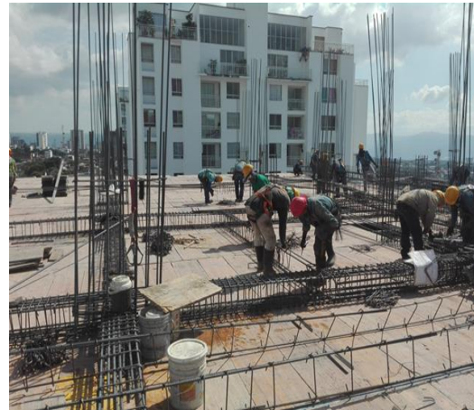
Figura 15. Armado de acero placa
