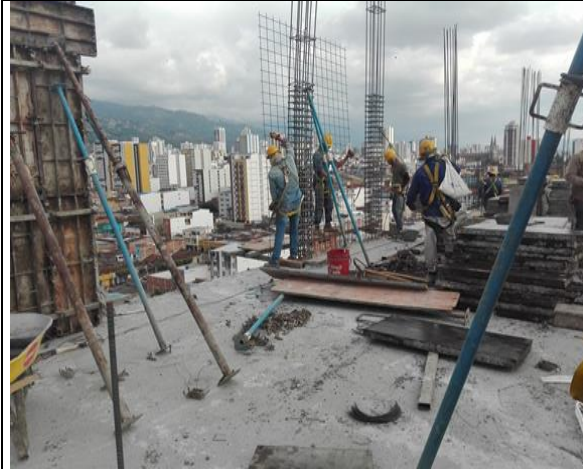
Figura 18. Armado columnas
