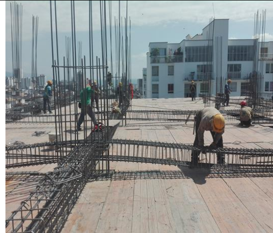
Figura 19. Armado viga
