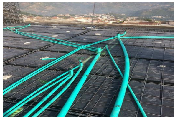
Figura 23. Tubería eléctrica, antes de fundir placa
