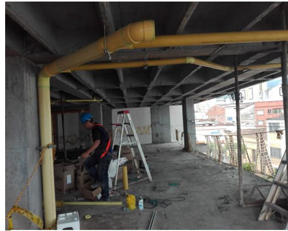
Figura 38. Tubería Sanitaria.
