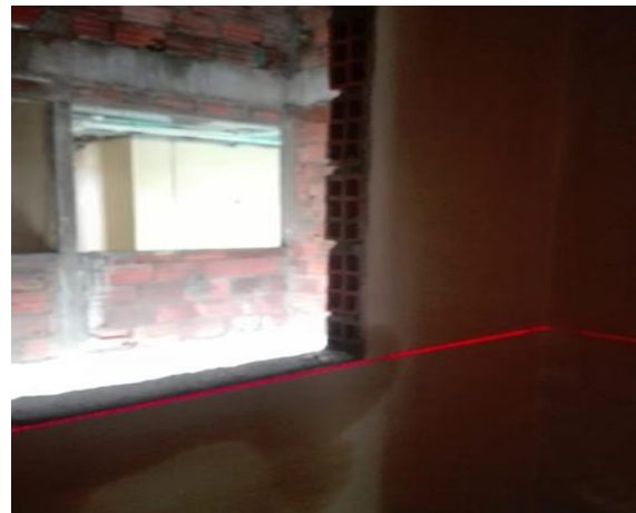
Figura 40. Laser para trasladar el nivel del punto fijo.
