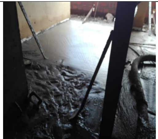
Figura 34. Vaciado mortero
