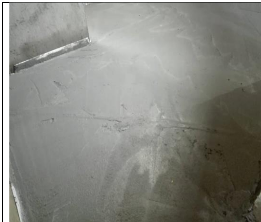
Figura 33. Nivelación mortero
