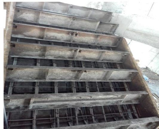
Figura 17. Armado acero escalera
