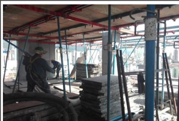
Figura 13. Colocación de tablero para placa
