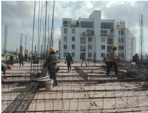
Figura 14. Armado de acero
