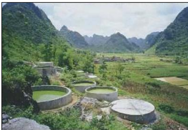
Figura 1. Tanques de almacenamiento proyecto “121”
