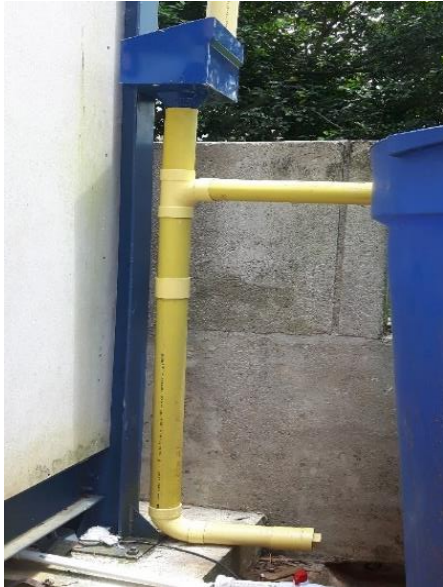
Figura 36. Interceptor de primeras aguas construido
