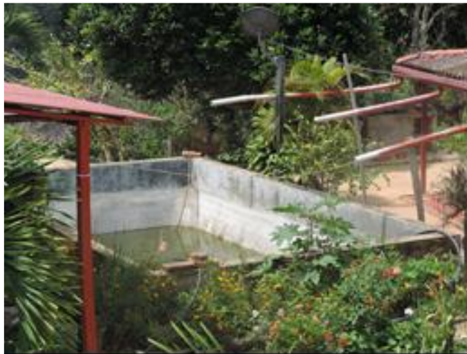
Figura 5. Tanque de almacenamiento en finca de Lebrija - Santander
