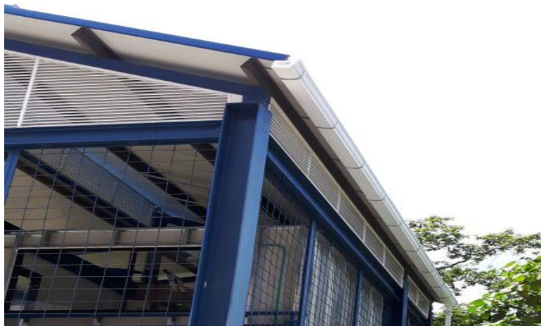
Figura 29. Canal borde lateral derecho
