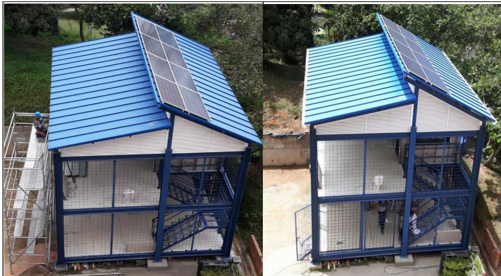
Figura 27. Instalación de tramos de canaleta
