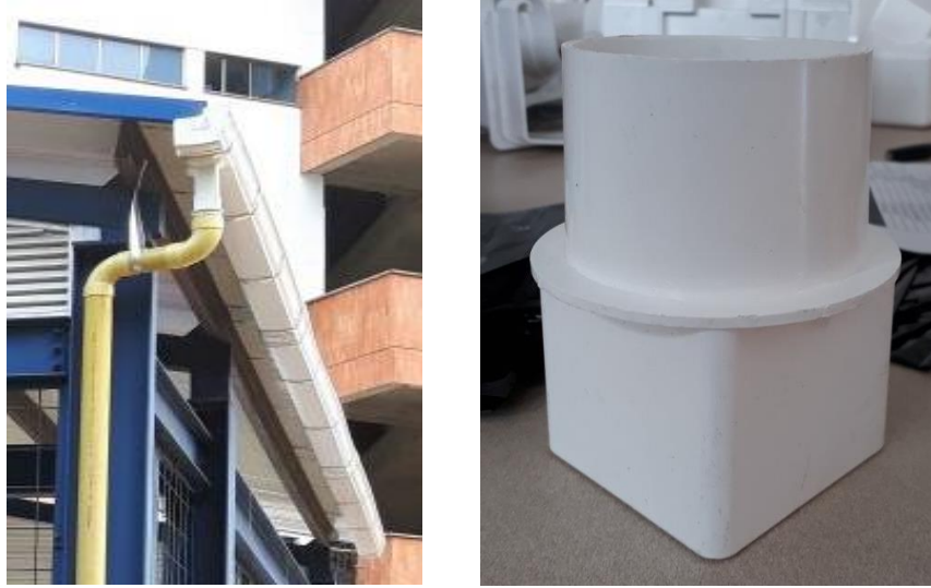
Figura 31. Convertidor cuadrado a redondo 3"
