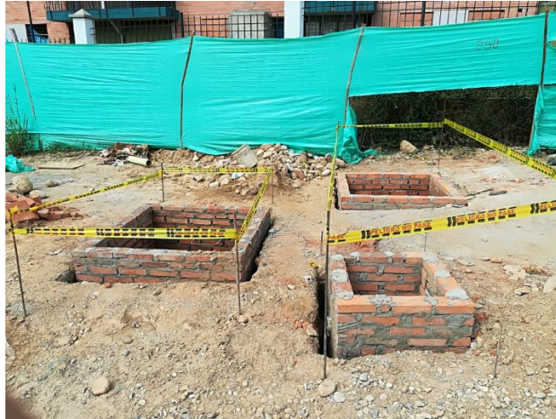
Figura 40. Construcción de las cajas eléctricas. Fuente: Autor.
