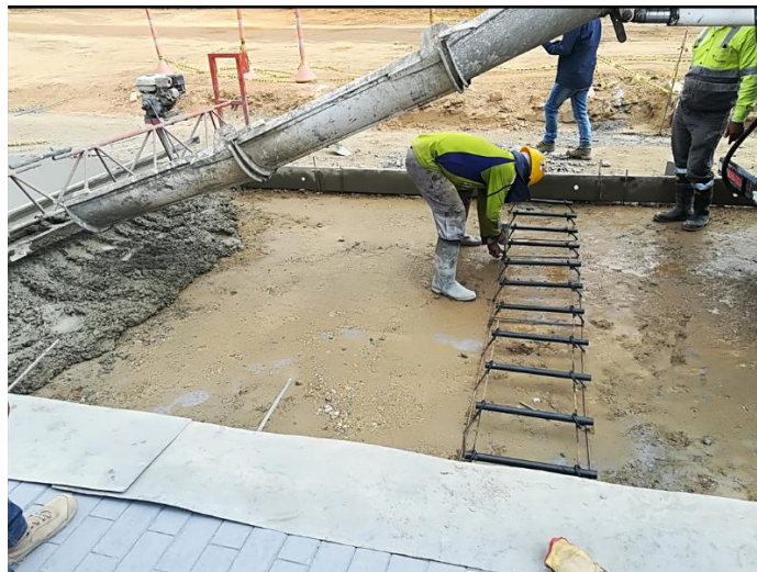
Figura 22. Instalación de la canastilla.
