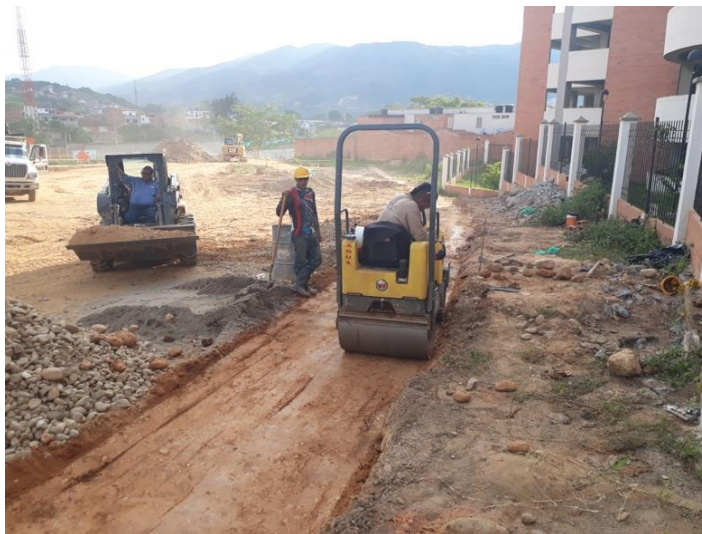
Figura 37. Compactación del relleno. Fuente: Autor.
