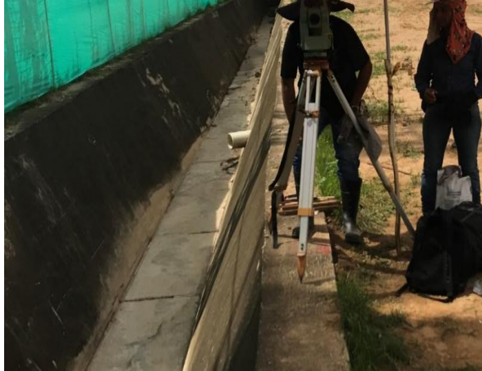
Figura 5. Canal Antiguo. Fuente: Consorcio Parque Lineal
