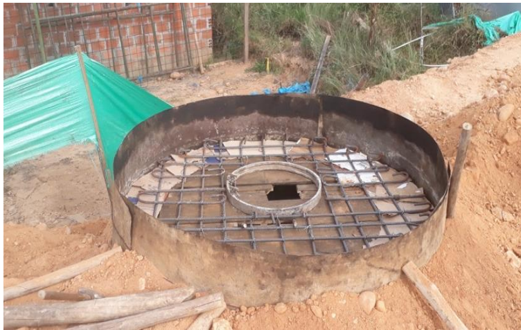
Figura 9. Formaleta y acero de refuerzo para fundir la corona del pozo. Fuente: Autor.
