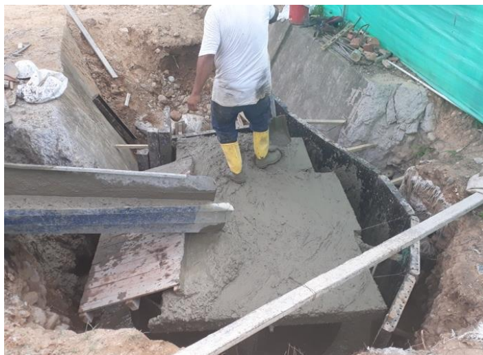
Figura 6. Instalación de formaleta y fundida del primer anillo del pozo. Fuente: Autor.
