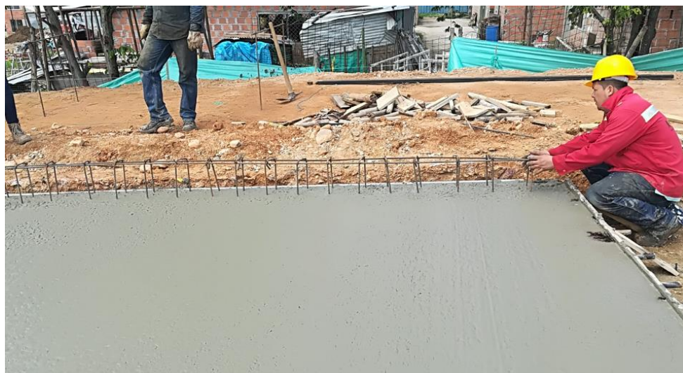
Figura 29. Acero de refuerzo para el sardinel.
