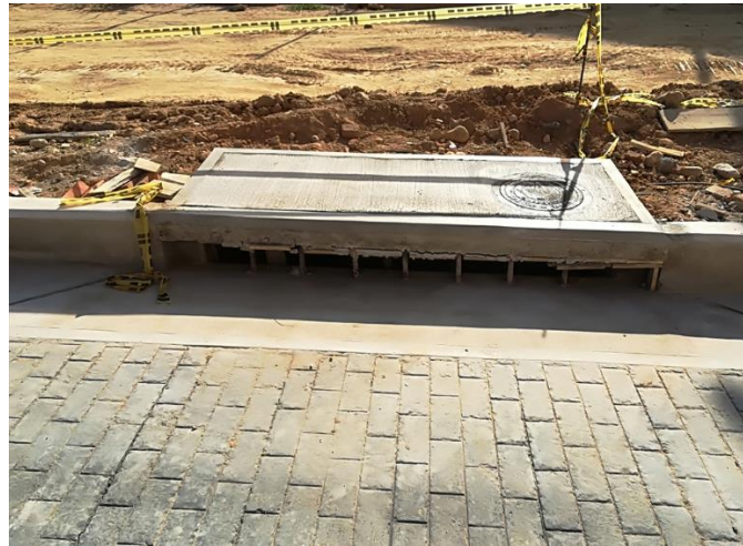
Figura 17. Fundición de placa 3000 psi e Instalación de aro y contra-aro. Fuente: Autor.
