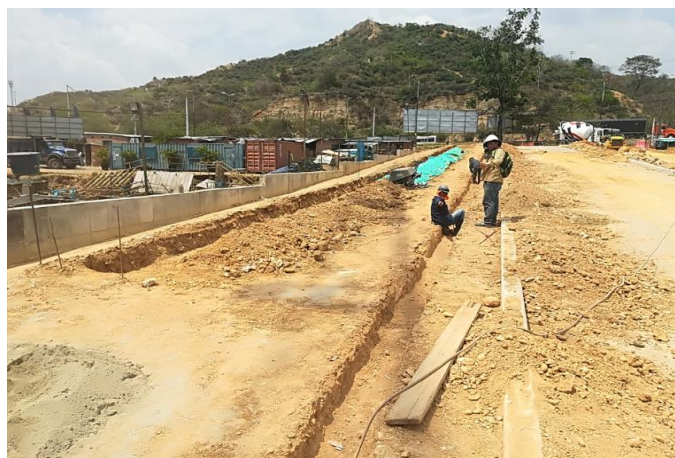
Figura 31. Excavación para el urbanismo. Fuente: Autor.
