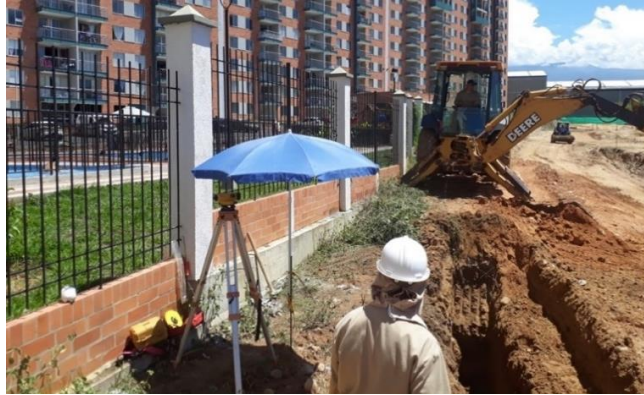
Figura 34. Excavación para la construcción del filtro. Fuente: Autor.
