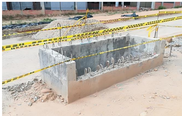
Figura 15. Fundida de las paredes del sumidero lateral. Fuente: Autor.
