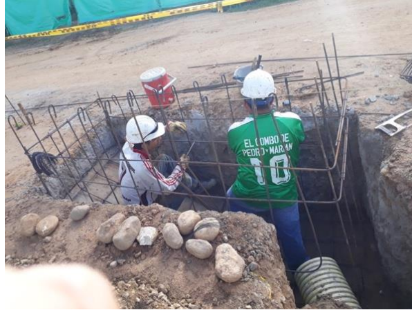
Figura 13. Armado e instalación acero de refuerzo del sumidero lateral. Fuente: Autor.
