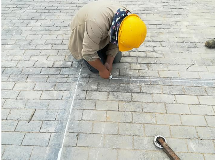
Figura 28. Aplicación del Sikaflex.
