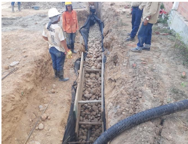
Figura 35. Instalación del geotextil, tubería perforada y piedra filtro. Fuente: Autor.
