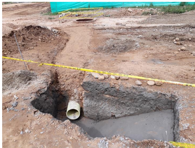
Figura 12. Instalación concreto de 2000 psi del sumidero lateral. Fuente: Autor.
