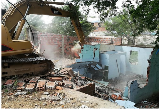
Figura 42. Demolición de viviendas. Fuente: Autor.
