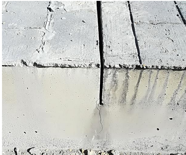
Figura 27. Junta de contracción. Fuente: Autor.
