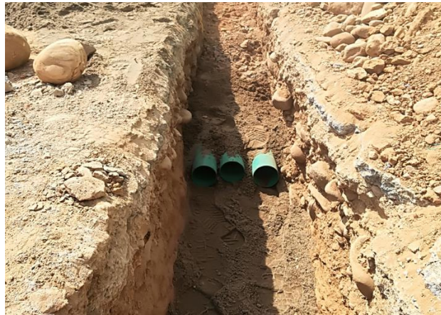
Figura 41. Relleno granular para la cimentación de los ductos eléctricos. Fuente: Autor.
