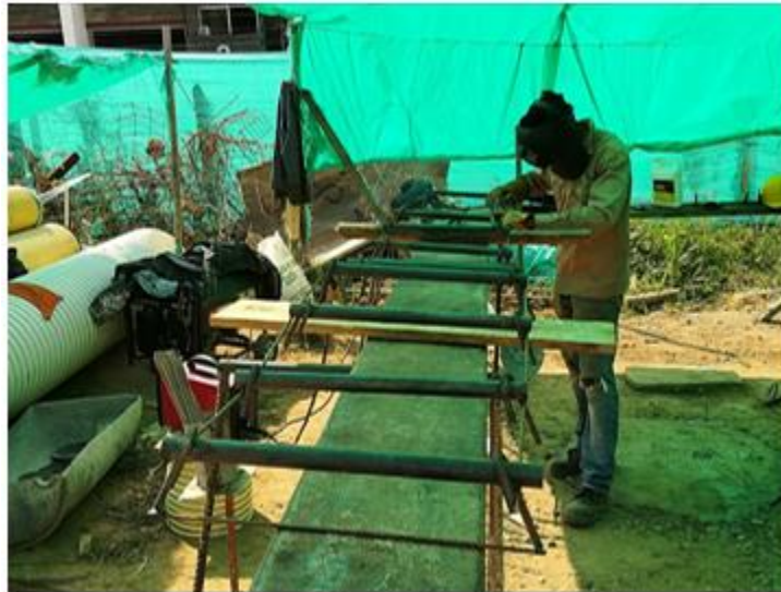
Figura 21. Suministro y fabricación de la canastilla. Fuente: Autor.
