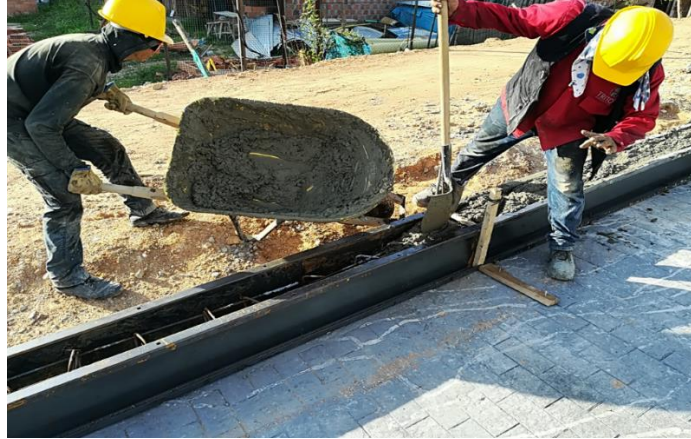
Figura 30. Fundida de sardinell en obra.
