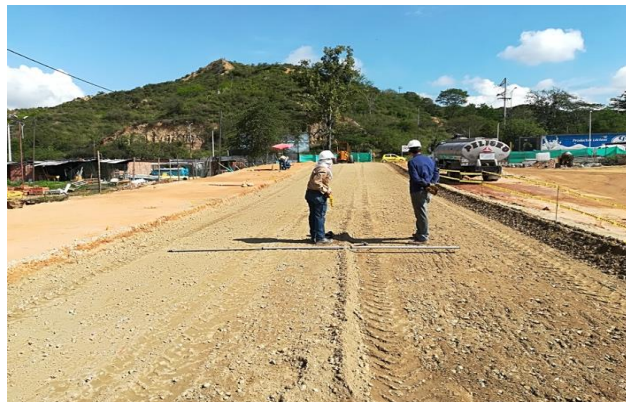
Figura 19. Instalación de la base con un espesor de 15 cm. Fuente: Autor.
