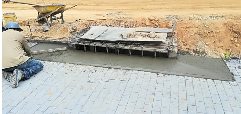
Figura 16. Fundida del babero para el sumidero lateral. Fuente: Autor.
