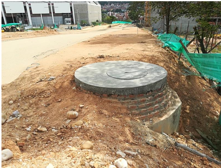
Figura 10. Finalizada la construcción del pozo y vista del canal. Fuente: Autor.
