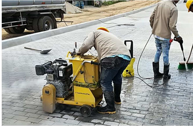
Figura 26. Dilatación de la losa. Fuente: Autor.
