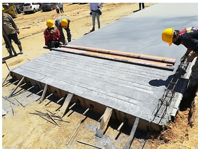
Figura 24. Estampado del pavimento en concreto hidráulico. Fuente: Autor.
