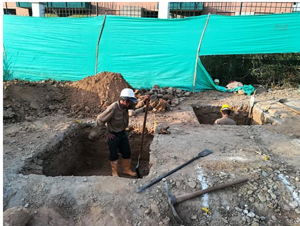
Figura 38. Excavación para la construcción de las cajas eléctricas. Fuente: Autor.
