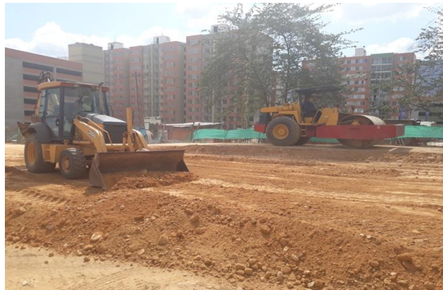
Figura 18. Mejoramiento de subrasante. Fuente: Autor.
