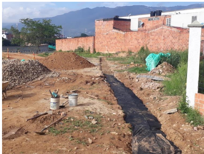
Figura 36. Geotextil sellado y relleno de la excavación. Fuente: Autor.
