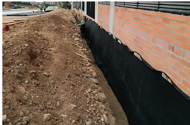
Figura 43. Instalación de geodren tubular. Fuente: Autor.
