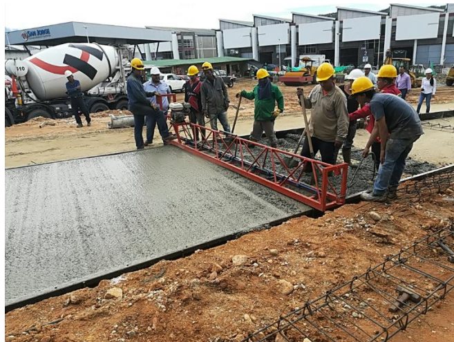
Figura 20. Fundida y vibrado del concreto MR-45. Fuente: Autor.
