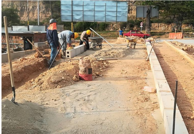
Figura 32. Instalación del bordillo recto. Fuente: Autor.
