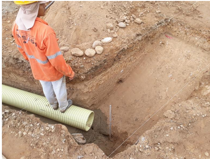
Figura 11. Excavación para la construcción del sumidero lateral SL200. Fuente: Autor.
