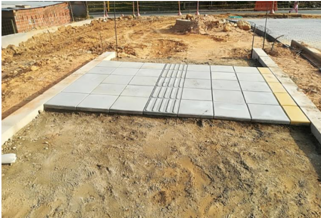
Figura 33. Instalación de la base y losetas de espacio público. Fuente: Autor.
