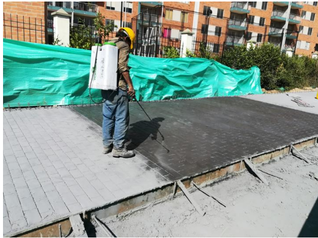
Figura 25. Aplicación del SIKA antisol-blanco. Fuente: Autor.
