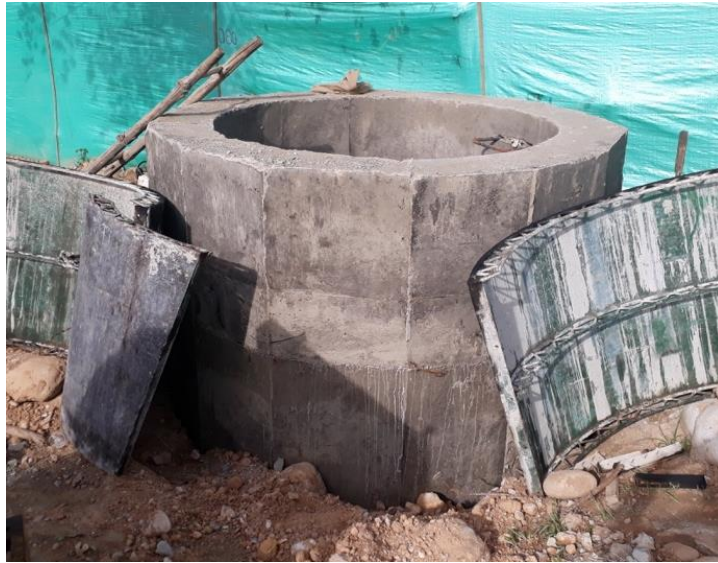
Figura 7. Desencofrado del segundo anillo del pozo. Fuente: Autor.
