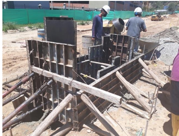
Figura 14. Instalación del encofrado del sumidero SL200. Fuente: Autor.
