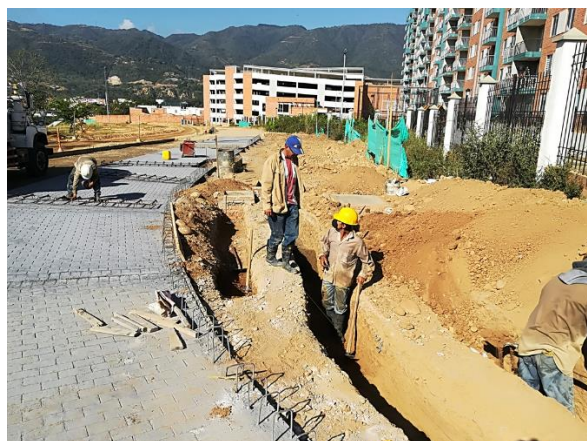
Figura 39. Excavación para los ductos eléctricos. Fuente: Autor.
