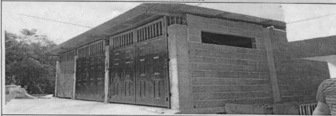
Observaciones: Construcción de vivienda.
