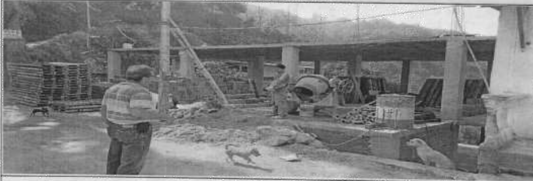
Observaciones: Construcción de vivienda.
