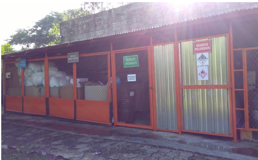
Imagen 1. CUARTO ALMACENAMIENTO DE RESIDUOS
