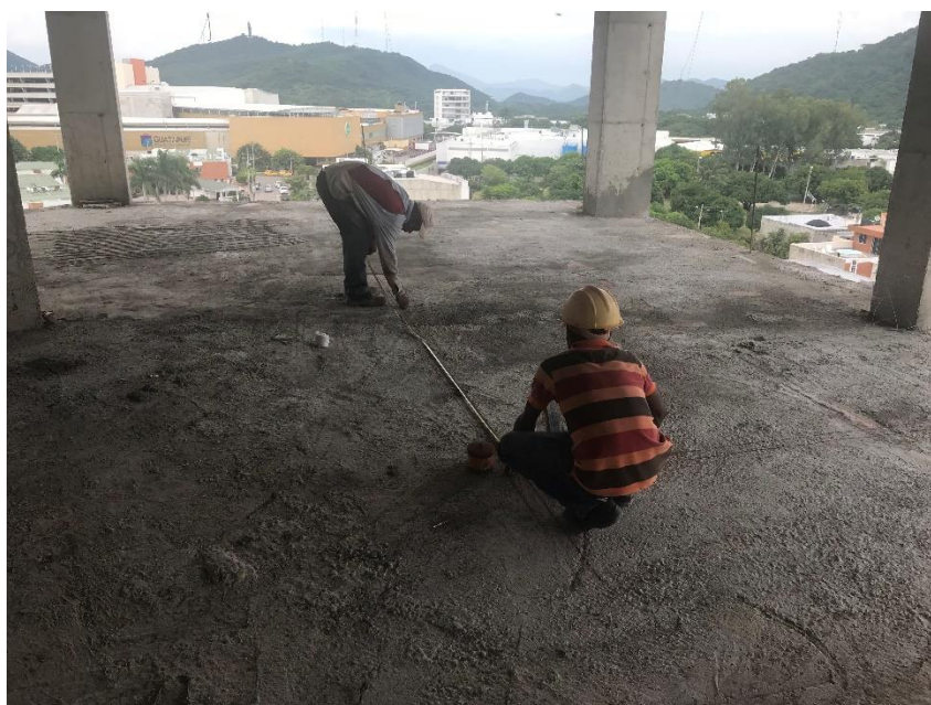
Figura 8: Trazado sobre placa piso 5.
