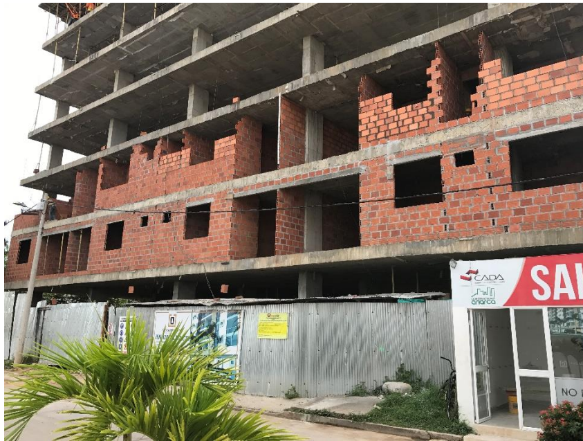
Figura 16: Fachada condominio San Sebastián 16/08/2017.
