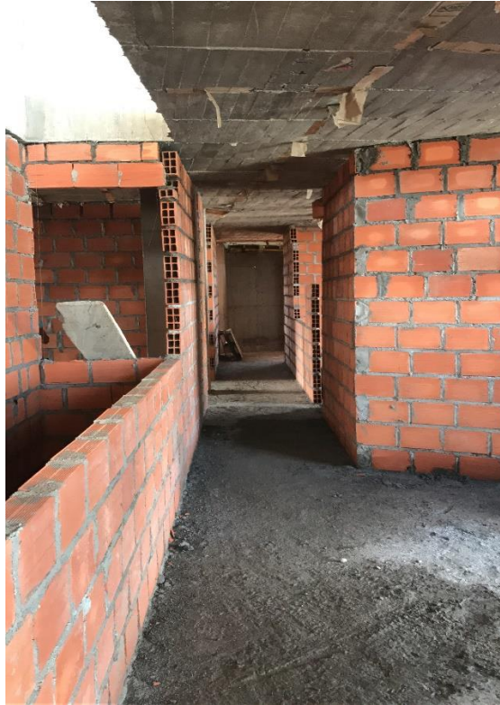
Figura 13: Levante muros zona común piso 5
