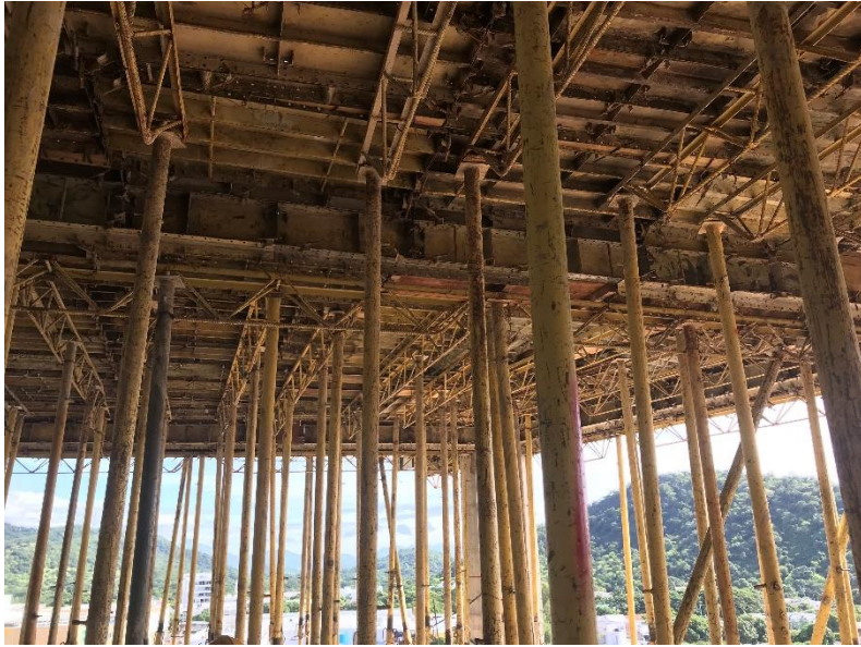
Figura 31: Encofrado placa 10 con formaleta metálica para vigas descolgada.
