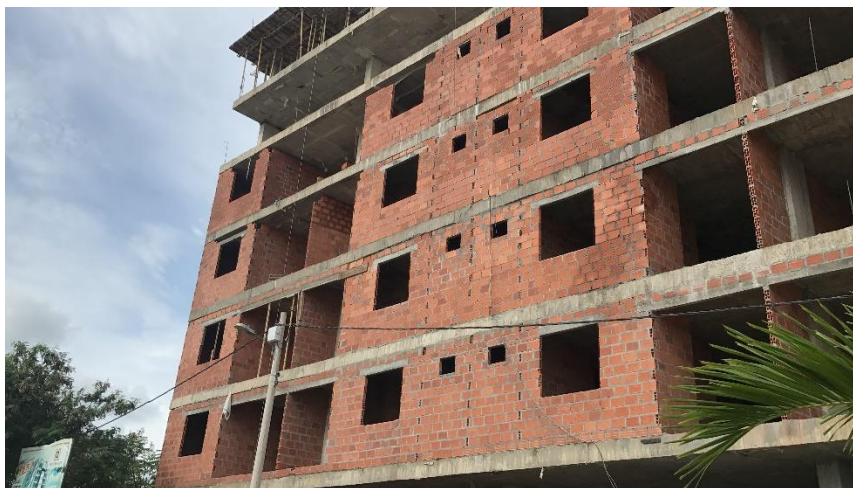
Figura 17: Fachada condominio San Sebastián 09/09/2017.
