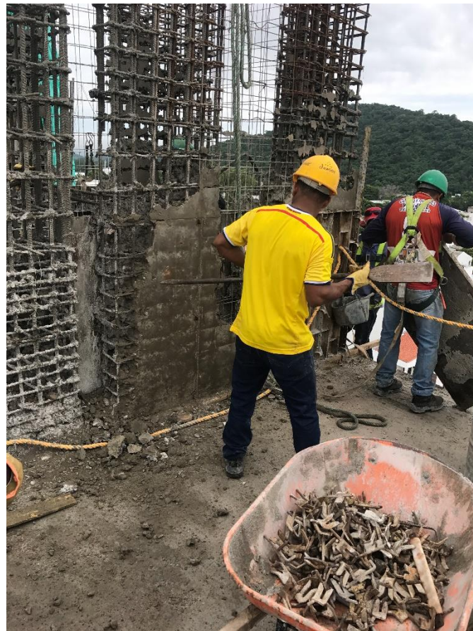
Figura 30: Demolición de concreto de ascensor que falló
