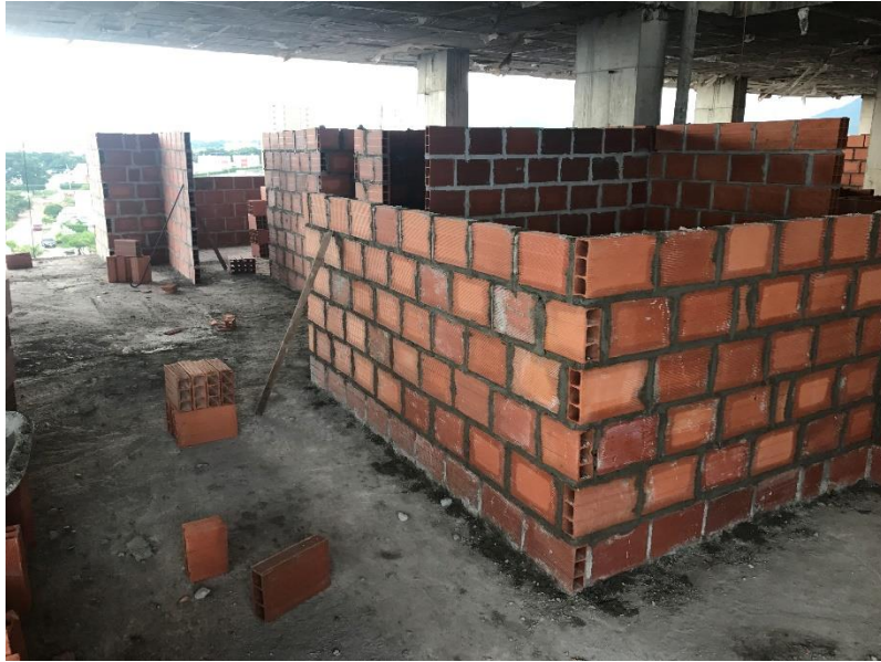
Figura 11: Proceso de construcción mampostería apartamento tipo 2 piso 4.
