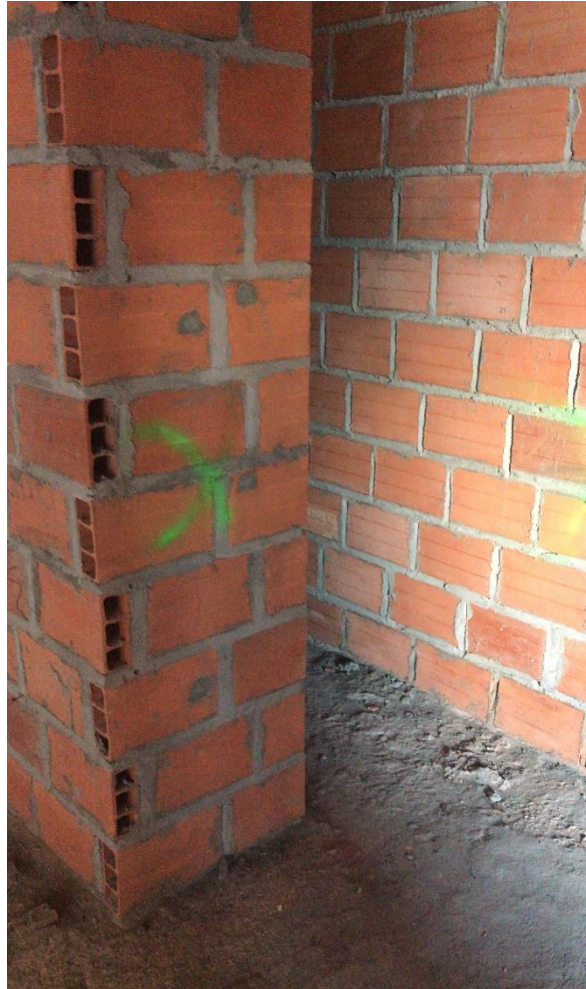
Figura 12: Levante muro metro lineal (ML).
