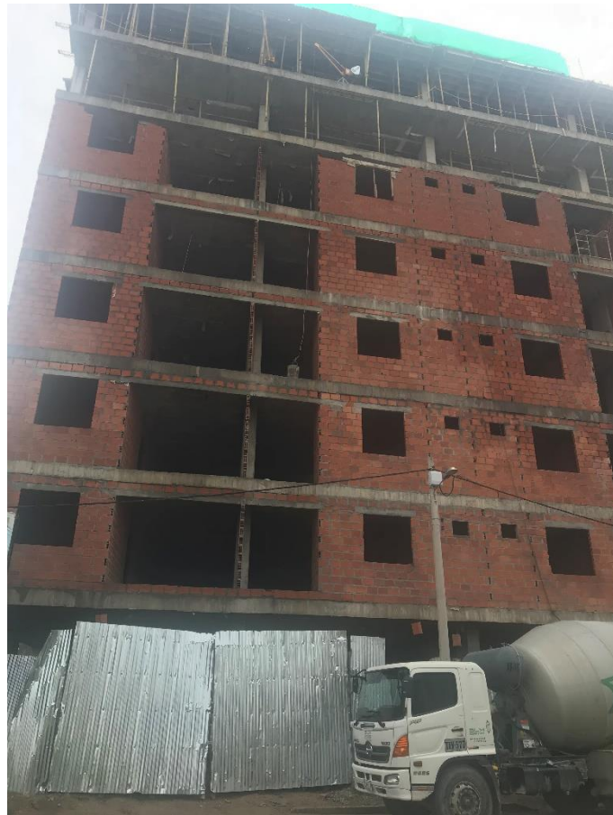
Figura 18: Fachada condominio San Sebastián 03/10/2017.
