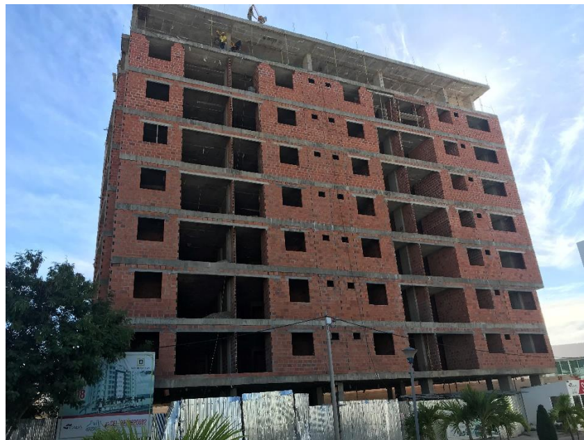
Figura 19: Fachada condominio San Sebastián 02/12/2017.
