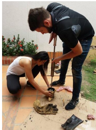
Fotografía 15. Proceso de compactación
