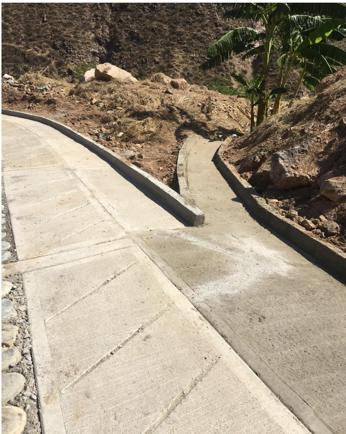
Ilustración 24: canal que deriva de la placa huella construida en la vereda Cabrera
