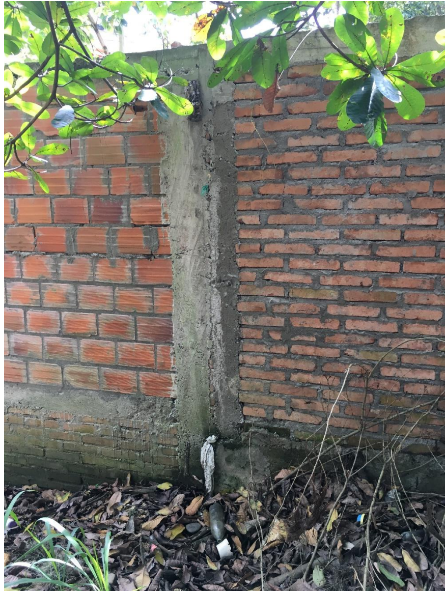
Ilustración 22: Muro que presenta movimiento por el tráfico vehicular que circula paralelo a la Escuela Normal Superior de Piedecuesta.
