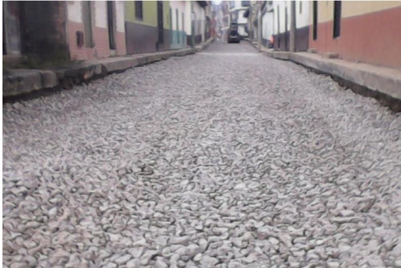
*Figura 7. Compactación del agregado grueso. Fuente: propia*
