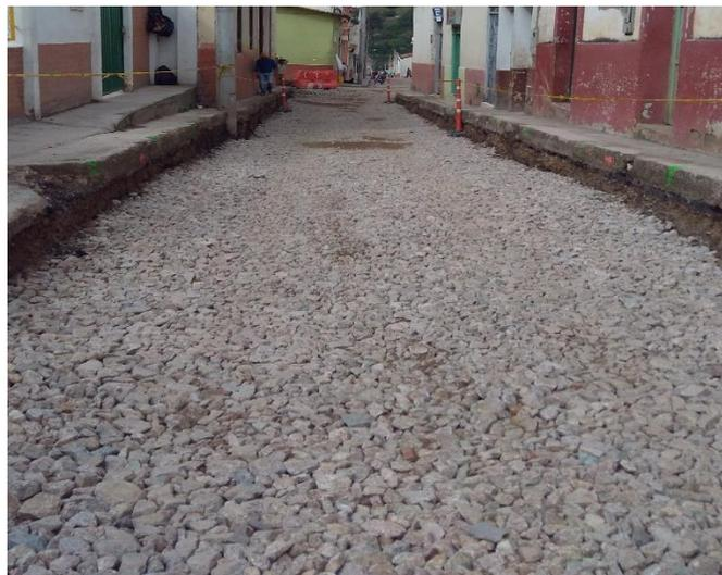
*Figura 6. Extendido de agregado grueso. Fuente: propia*
