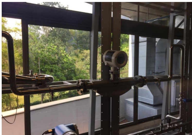
Figura 15: Instalación del sensor de flujo.
