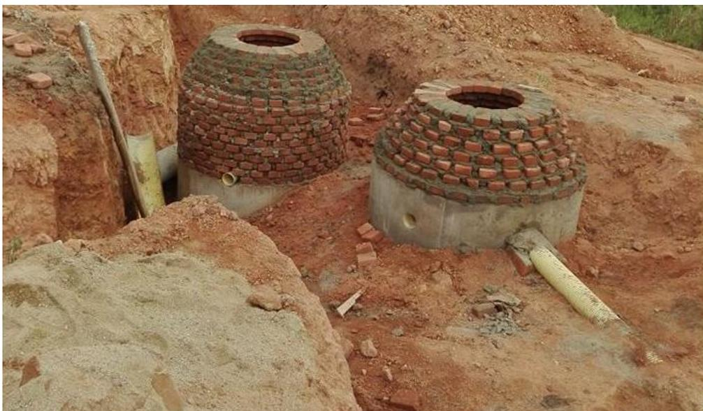
*Ilustración 23: pozo terminado con sus respectivos pases.*
