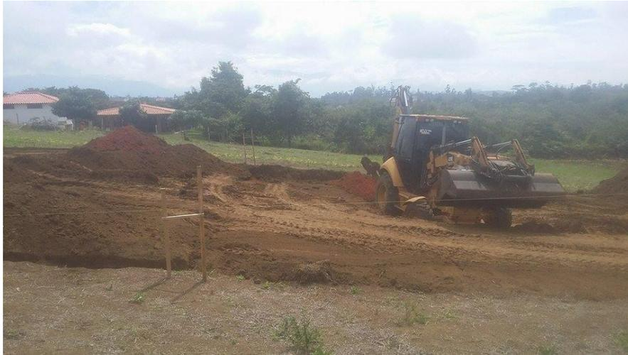
*Ilustración 11: control y supervisión de niveles de relleno.*
