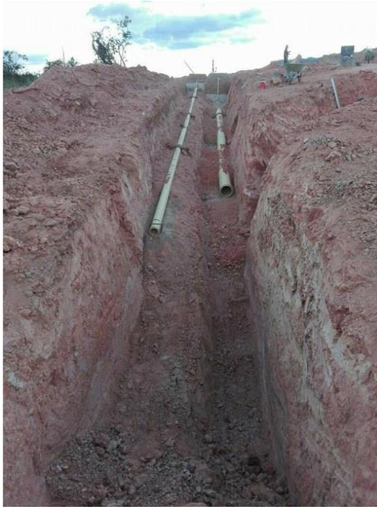
*Ilustración 25: control de pendiente de tubería*
