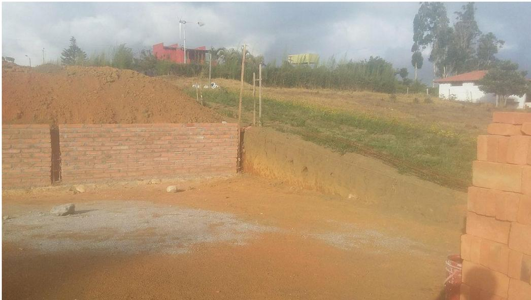
*Ilustración 17: muro de mampostería terminado.*
