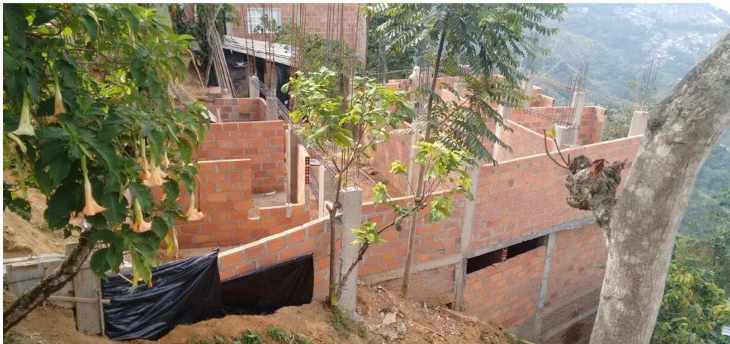
Imagen 10 Construcción de edificación sobre talud en desnivel sin el debido cumplimiento de los parámetros sismoresistentes estipulados en la NSR-10 - Predio ubicado en la Vereda El Pedregal
