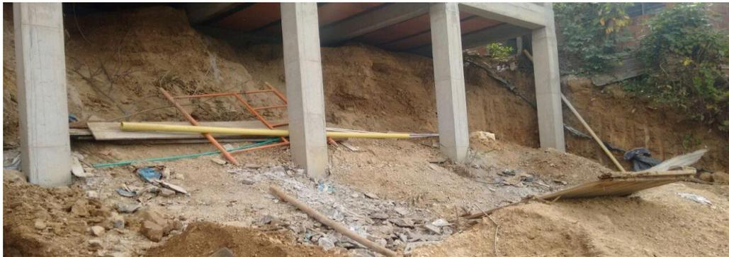
Imagen 9 Construcción de edificación de Cuatro (4) pisos de Altura sobre talud en desnivel sin ningún estudio de suelos- Predio ubicado en la Vereda El Pedregal
