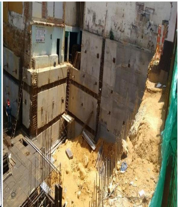
Imagen 7 Excavaciones Profundas- Visita al predio ubicado en la Calle 30 no. 24-19/21/25
