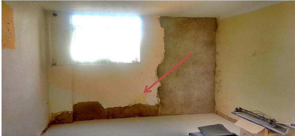
Imagen 26 Perturbación a la Posesión- Daño de Muros Interiores por Construcción de Vecinos Colindantes
