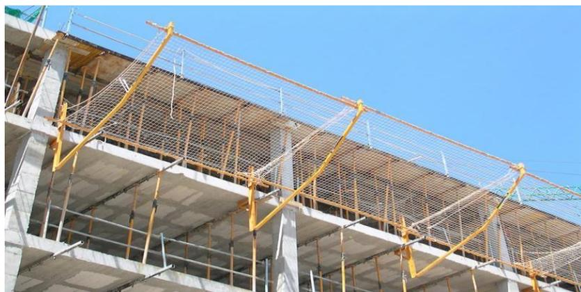
Figura 5 Mallas de Protección para garantizar la seguridad de los peatones (www.colombianademallas.com)
