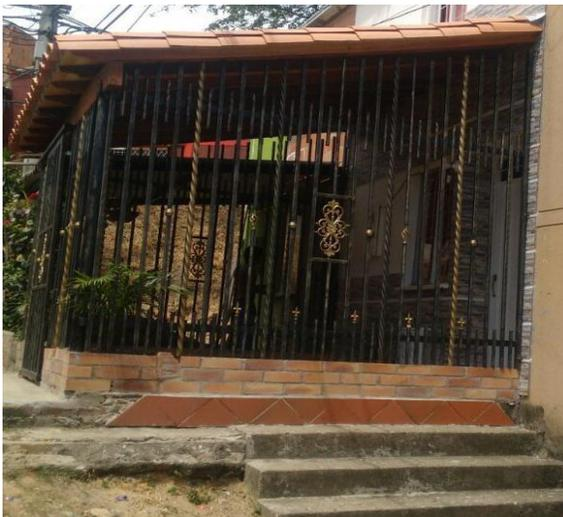
Imagen 15 . Encerramiento de Antejardín con Muro Bajo, Reja Metálica y Cubierta en madera y teja de arcilla
