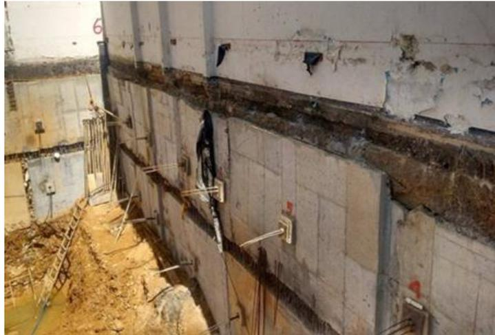
Imagen 6 Muros Anclados- Visita al predio ubicado en la Carrera 34 no. 55-108/110
