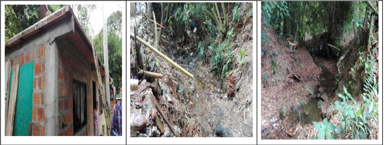
Proyecto: Barrio Tamboruco, construcción sobre la franja de aislamiento de un cauce secundario. Floridablanca
