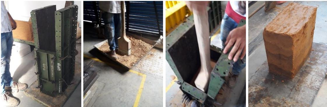
Fotografía 4. Proceso construcción muretes (Autores)
