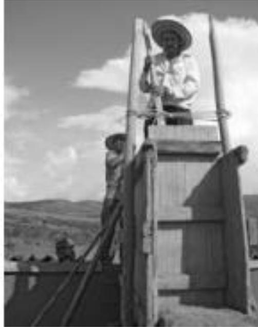
Imagen 4. Construcción muro en tapia pisada con encofrados artesanales tomado (Rivero Bolaños, 2007)
