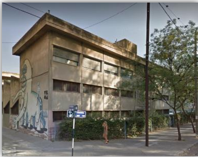
Figura 2 - Edificación de Laboratorio de Metalurgia
