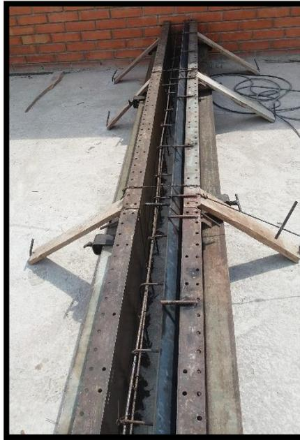
Imagen 6. Formaleta para bordillos en concreto reforzado para jardineras en terraza. Fuente: Autor.
