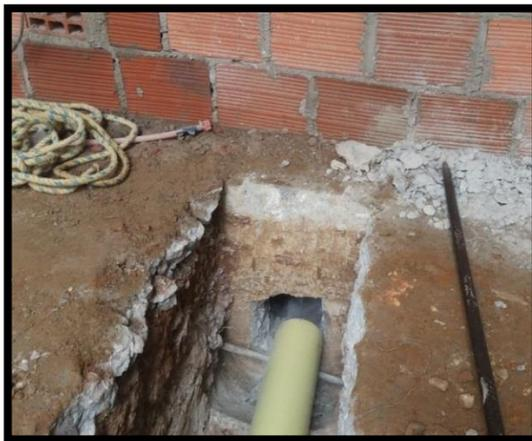
Imagen 3. Perforación en concreto reforzado para pase de tubería sanitaria. Fuente: Autor.
