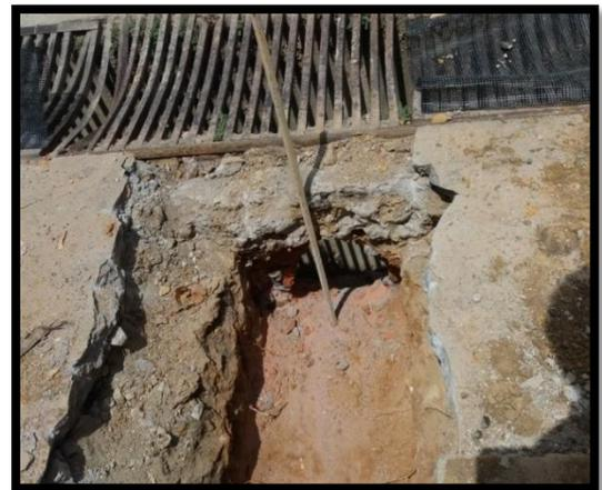
Imagen 4. Perforación en concreto reforzado para pase de tubería aguas lluvias. Fuente: Autor.
