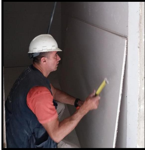
Imagen 2. Medición en conjunto para corte de obra con personal de muros en drywall. Fuente: Autor.
