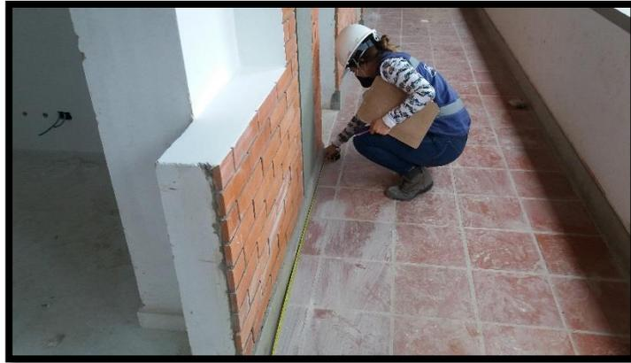
Imagen 1. Medición en campo de guarda escobas en concreto reforzado. Fuente: Autor.
