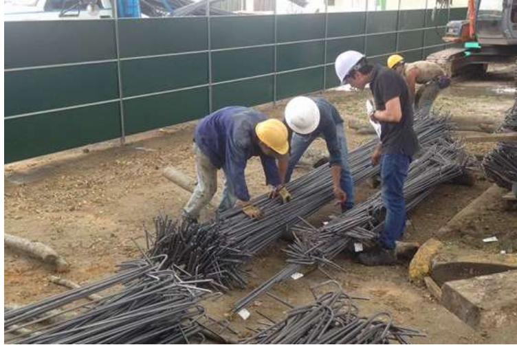
Figura 7. Conteo de varillas de acero en obra. Fuente: Propia.
