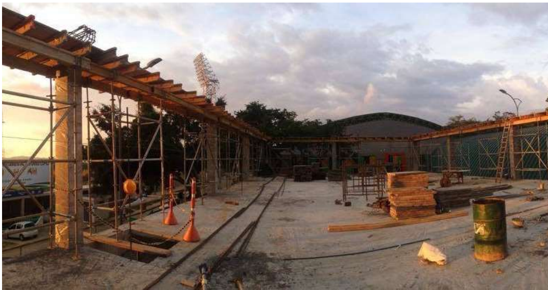
Figura 3. Construcción del coliseo de combate. Fuente: Propia
