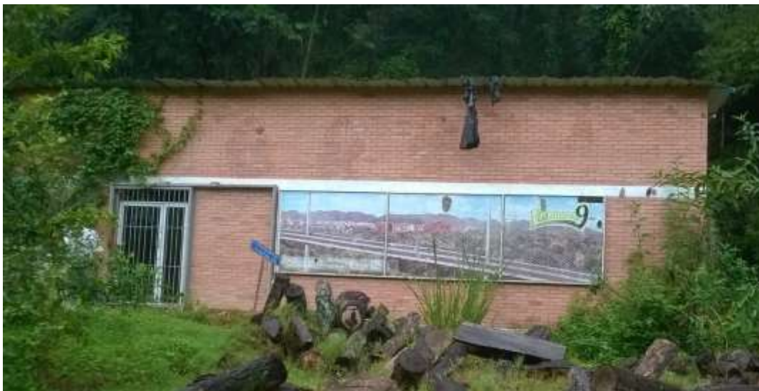
Figura 7: Vista Frontal, Instalaciones Planta Piloto.
