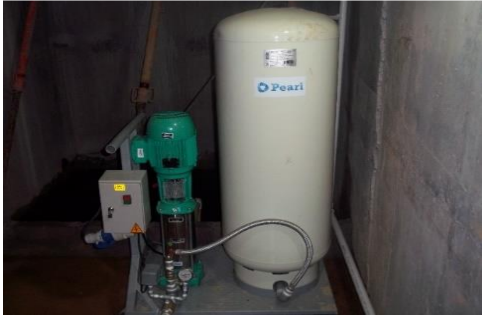
FUENTE:(el autor) HG CONSTRUCTORA PROYECTO SMART JUNIN
