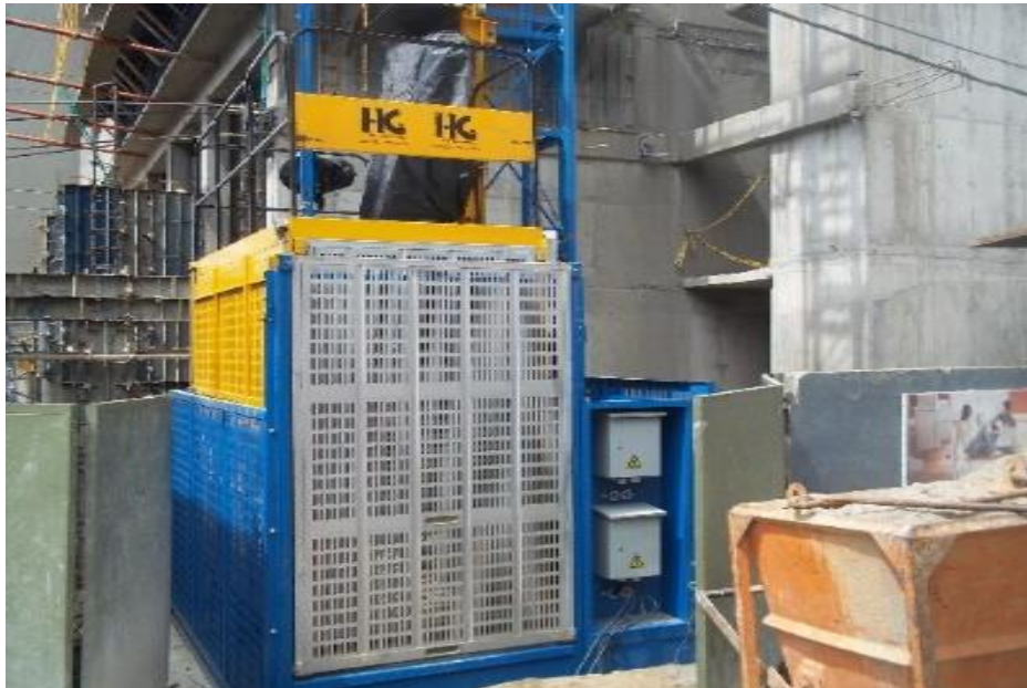
FUENTE:(el autor) HG CONSTRUCTORA PROYECTO SMART JUNIN
