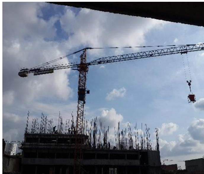
Figura 10: Imagen equipo principal TORRE GRUA POTAIN NCZ 428TG01
