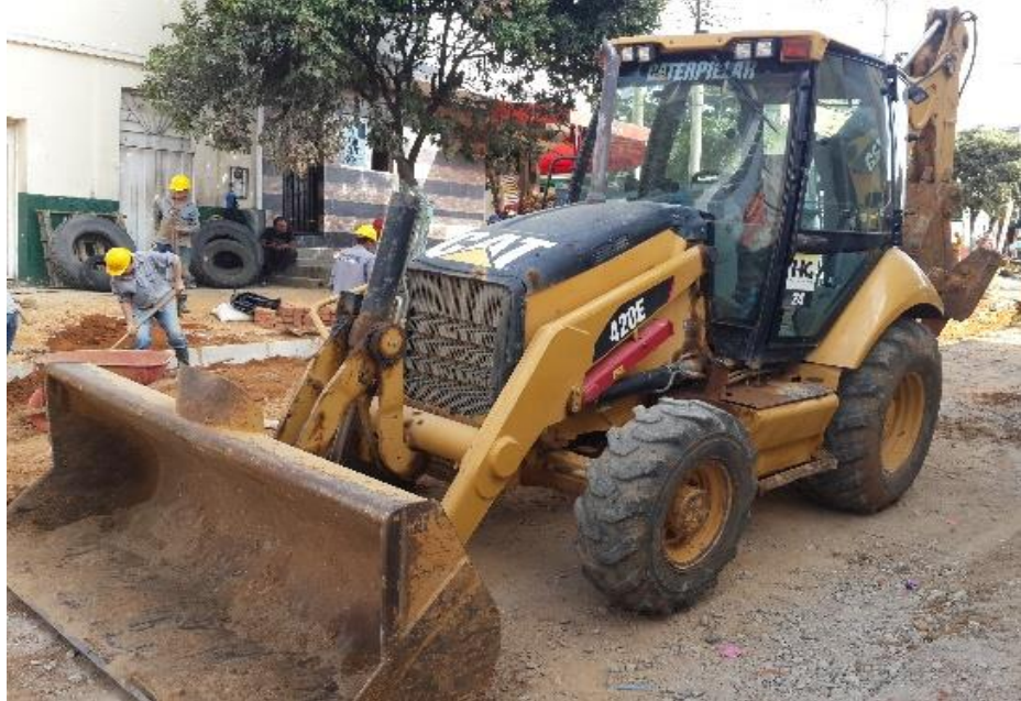
FUENTE:(el autor) HG CONSTRUCTORA PROYECTO SMART JUNIN
