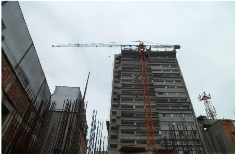
Figura 11: Imagen equipo principal TORRE GRUA POTAIN NCZ 428TG02
