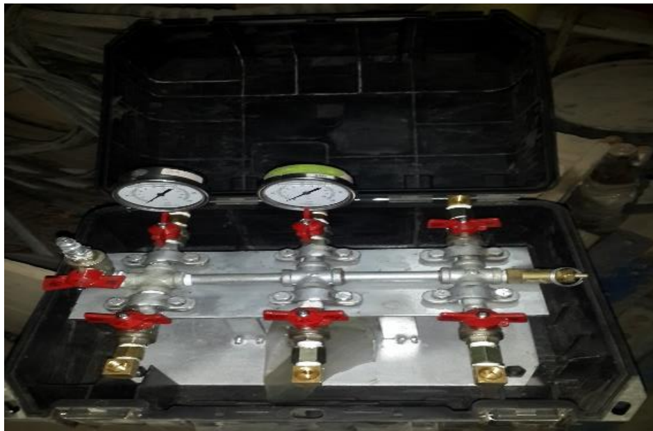
FUENTE:(el autor) HG CONSTRUCTORA PROYECTO SMART JUNIN
