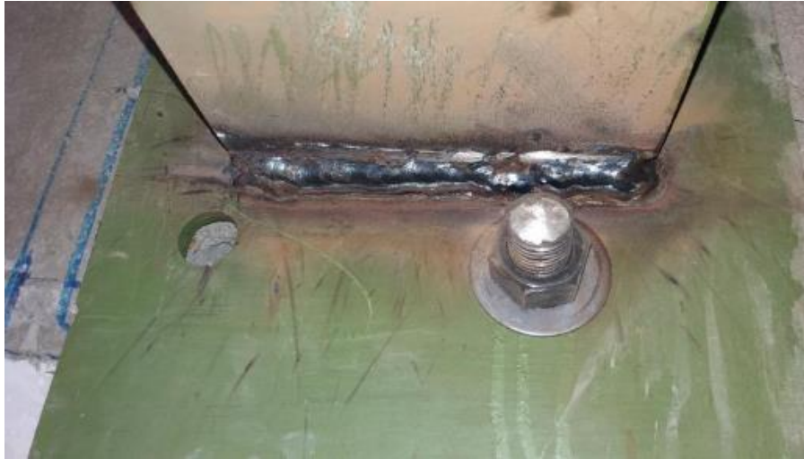
Figura 23. Soldadura entre viga IP y platina.
