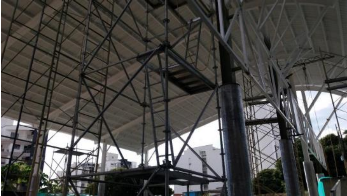
Figura 14. Cubierta metálica con tejas instaladas y frontones en proceso (avance de 80%).
