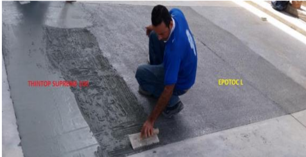
Figura 17. Aplicación de Epotoc L y Thintop Supreme 100 en el arreglo de la losa dañada.
