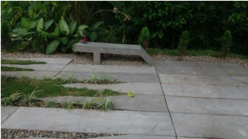
Figura 30. Banca y losas de concreto elaboradas con material residual.
