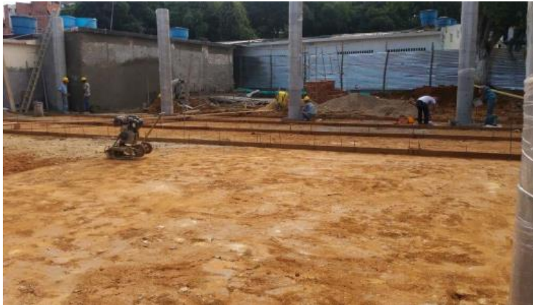
Figura 8. Replanteo y división para la fundida de losas en concreto.
