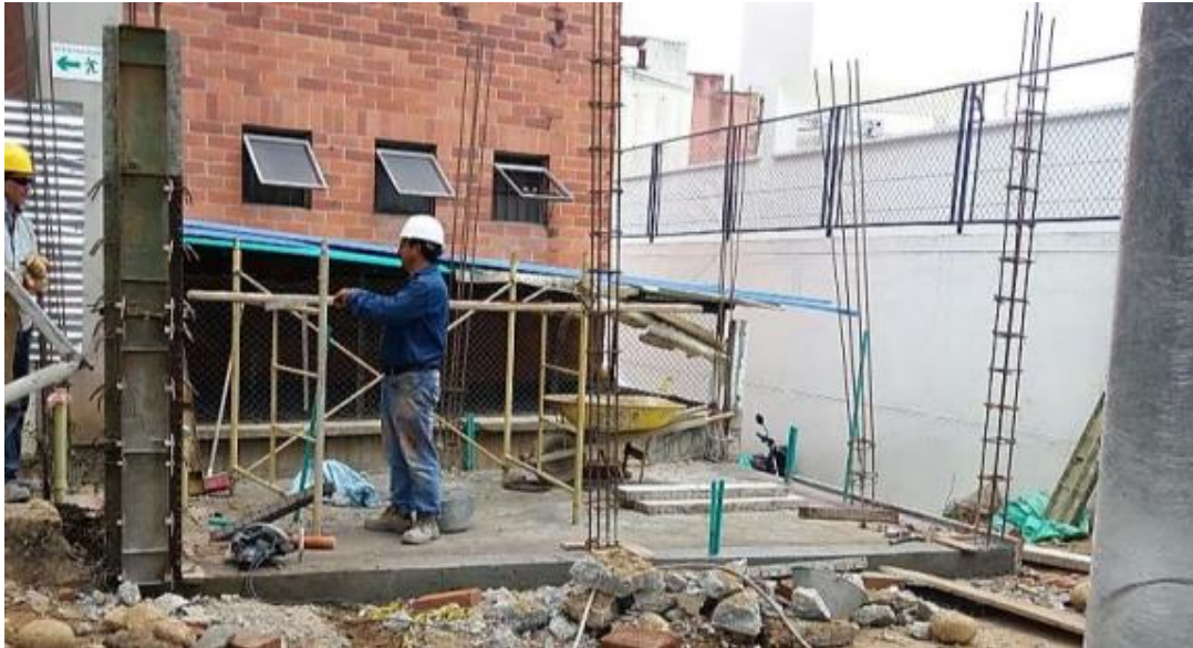
Figura 15. Construcción columnetas en la enfermería.
