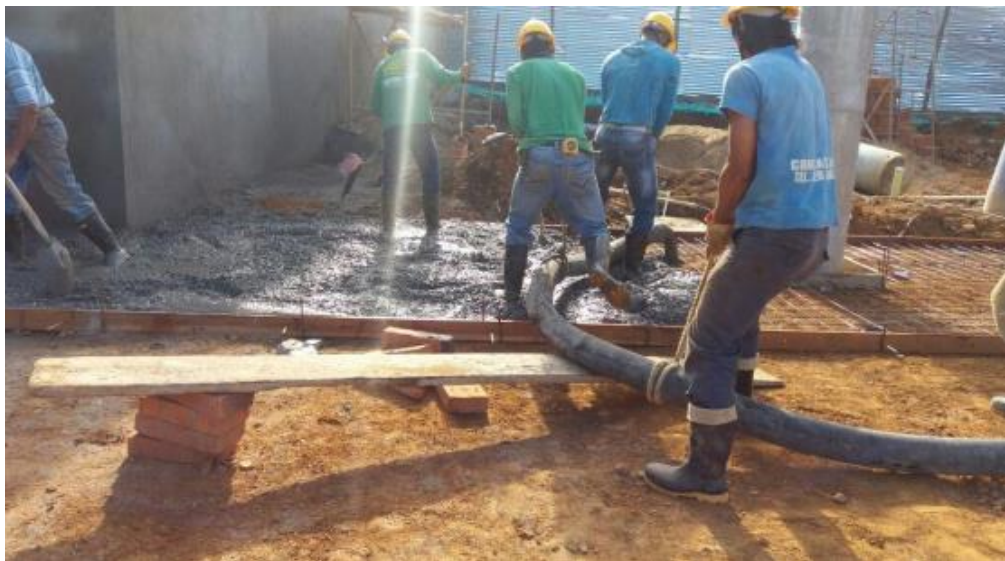
Figura 10. Fundida de la primera losa con bomba.
