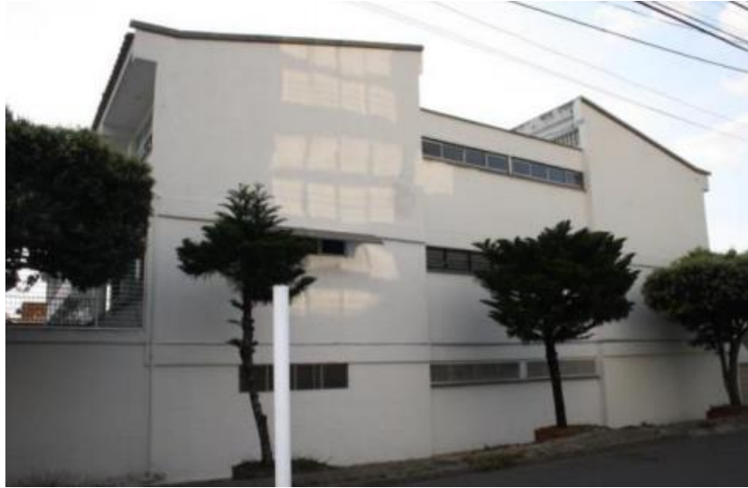
Figura 4. Vista fachada oriental bloque de aulas, tomado del Estudio de vulnerabilidad sísmica, LSJ Ingeniería, consultoría y construcción.
