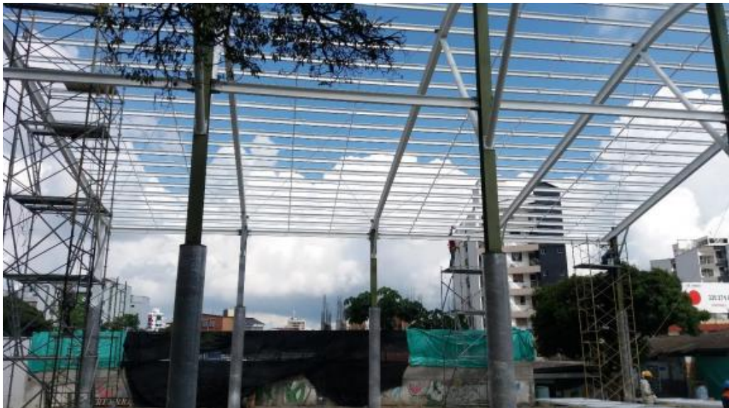
Figura 13. Esqueleto de la estructura metálica (vigas, correas y tensores).
