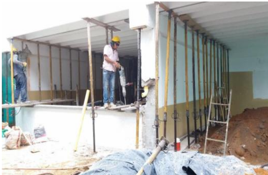
Figura 19. Parales colocados a los laterales de las vigas cargueras eje 2 entre ejes C y D.
