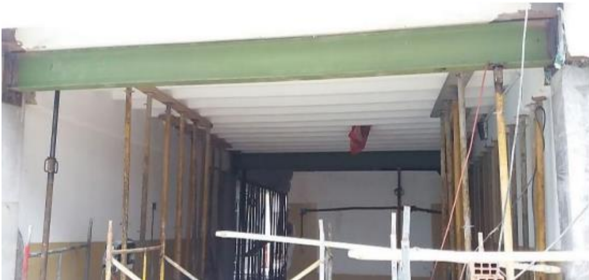
Figura 7. Viga IP desde columna D-2 a columna D-3.
