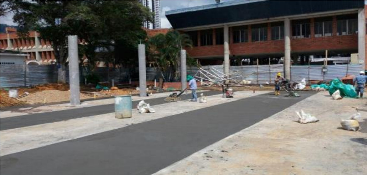
Figura 12. Uso del helicóptero para el acabado de la segunda fundida de losas.
