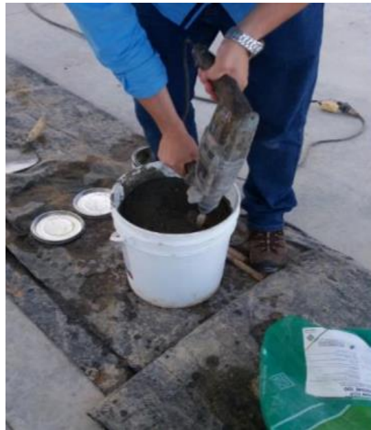
Figura 16. Preparación de Thintop Supreme 100.
