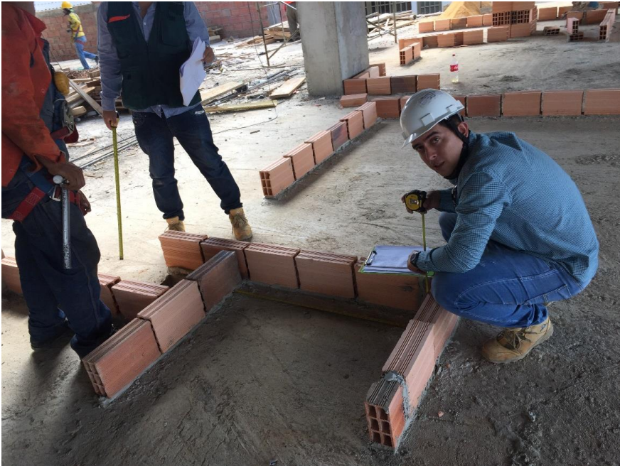
Figura 15, Revisión de Replanteo de Mampostería.
