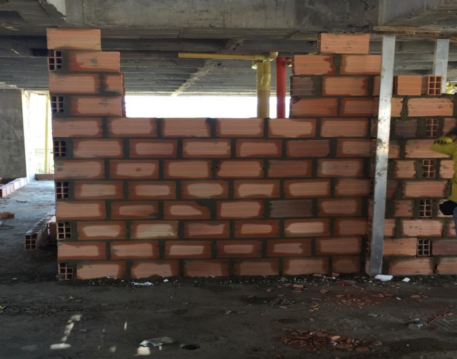
Figura 20, Muro de mampostería.
