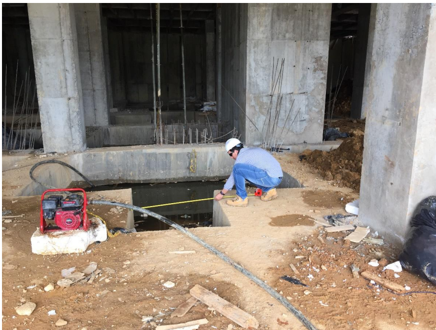
Figura 14, Cubicación para rellenos.
