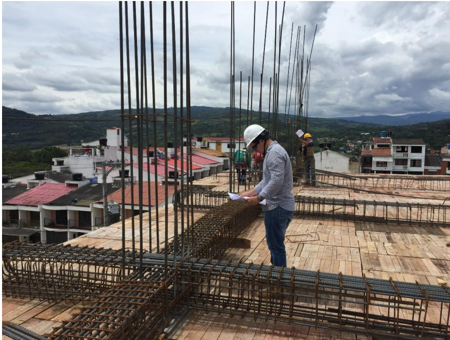
Figura 13, Revisión de acero de vigas.
