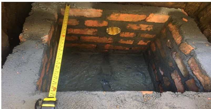
Imagen 9 Construcción pozo de inspección
