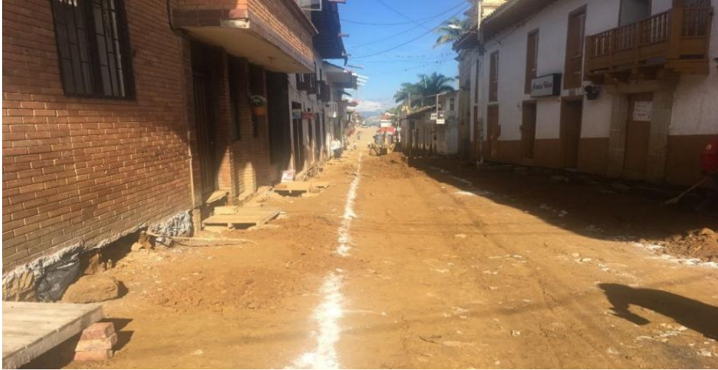
Imagen 7 Replanteo extremos de la vía
