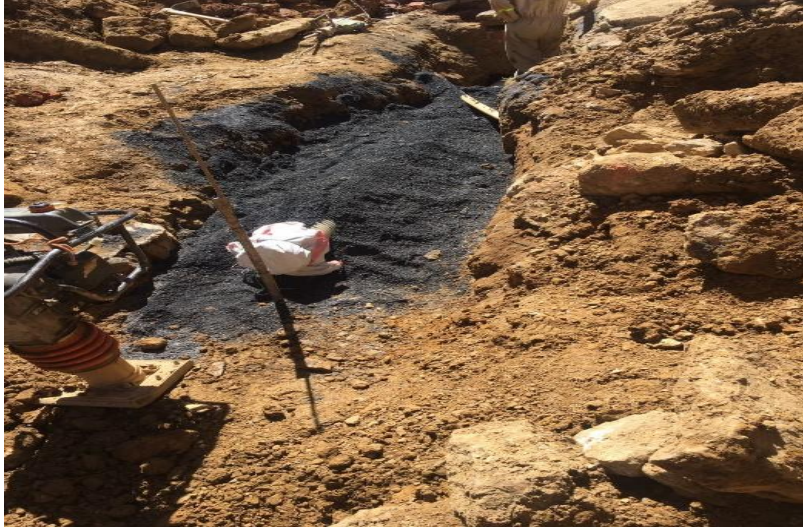
Imagen 11 Cama de arena para tubería de PVC
