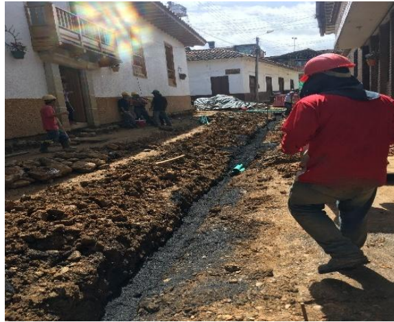
Imagen 13 Cama de arena para tubería eléctrica
