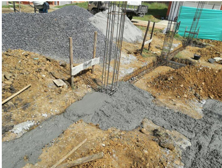
Imagen 18 Fundida de zapata
