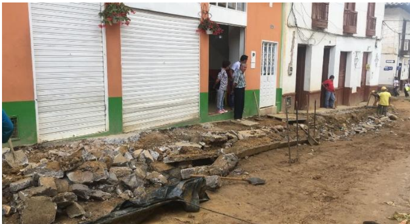
Imagen 12 Demolición de andenes
