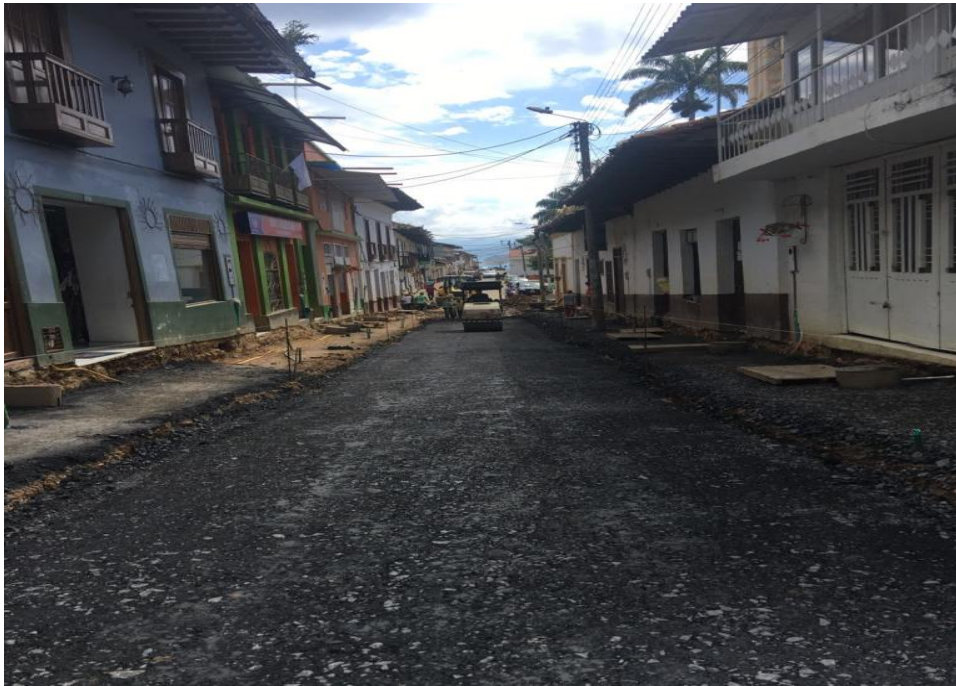
Imagen 15 Base granular extendida y compactada
