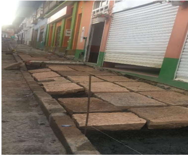
Imagen 16 Concreto de 3000 PSI para asentar piedra
