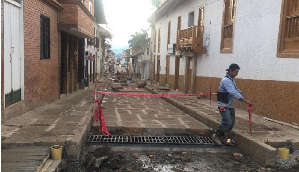
Imagen 17 Cárcamo en concreto reforzado Fuente: Edgar Machuca
