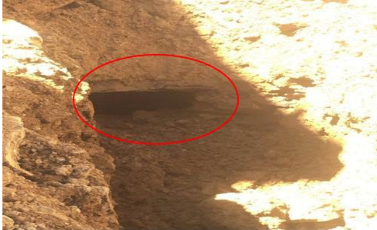
Imagen 8 Box culvert en piedra
