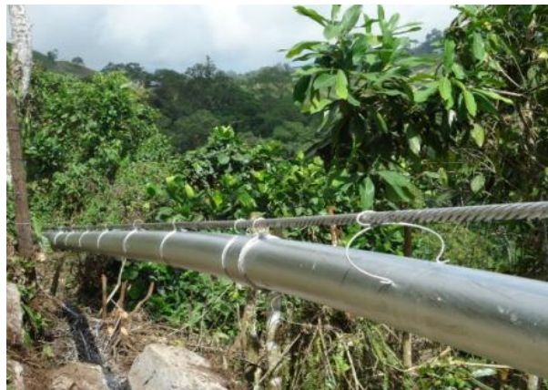
Foto 1. Instalación de Aéreos
