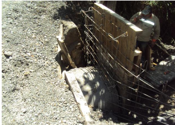
Foto.24 Formaleta y refuerzo, cabeza de entrada de alcantarilla
