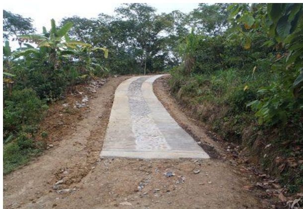
Foto.56 Huellas Agua Blanca
