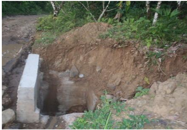
Foto.77 Alcantarilla la Pedregosa
