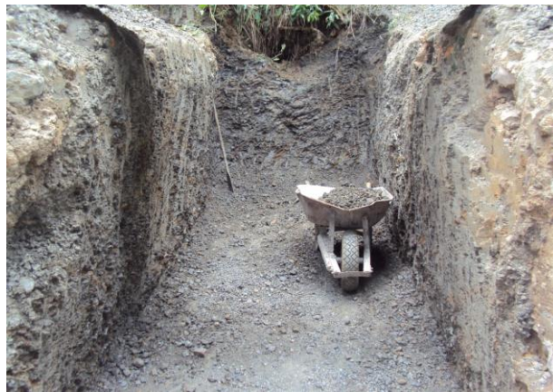
Foto.19 Dimensiones de la excavación para alcantarilla
