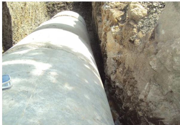
Foto.23 Instalación de tubería de alcantarilla
