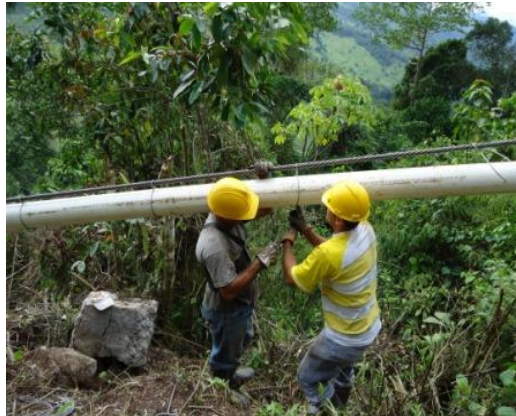
Foto 6. Instalación de Aéreos
