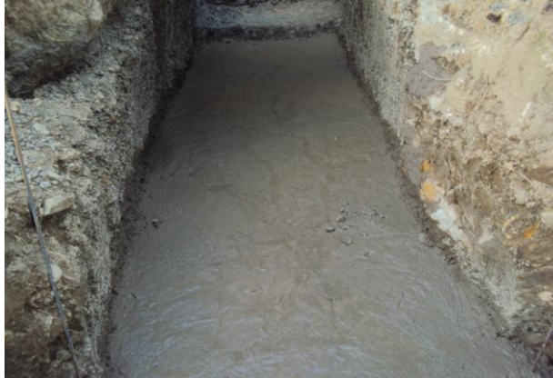
Foto.22 Solado en el fondo de la excavación
