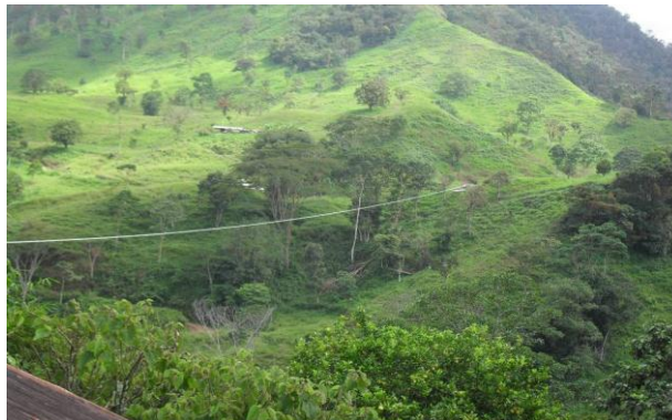
Foto 3. Instalación de Aéreos
