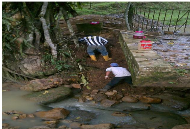
Foto.29 Excavaciones para aletones del puenton (Palo Tigre)
