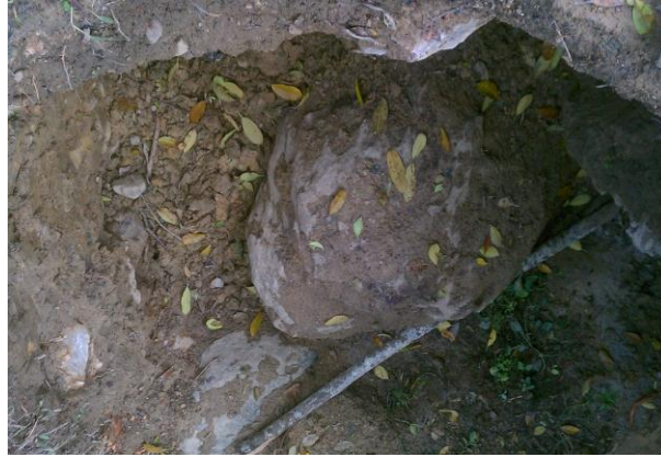
Foto.30 Excavaciones para aletones del puenton
