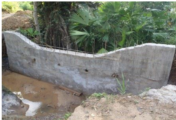
Foto.39 Muro en concreto reforzado
