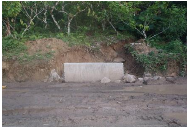
Foto.78 Alcantarilla La Pedregosa
