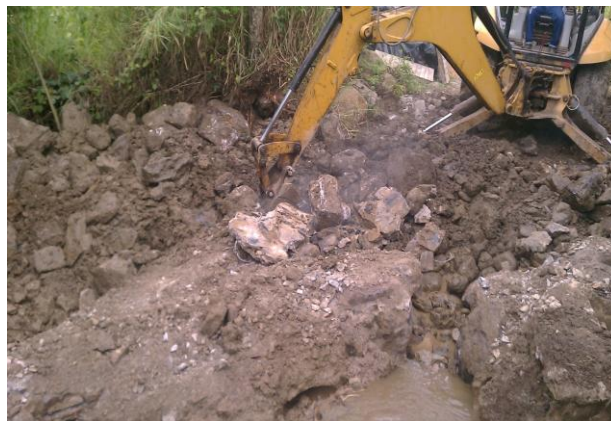
Foto.42 Demolición de estructura existente
