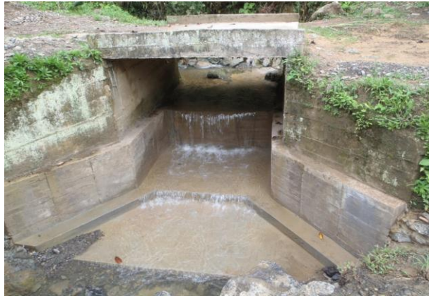
Foto.38 Estado final de la obra.
