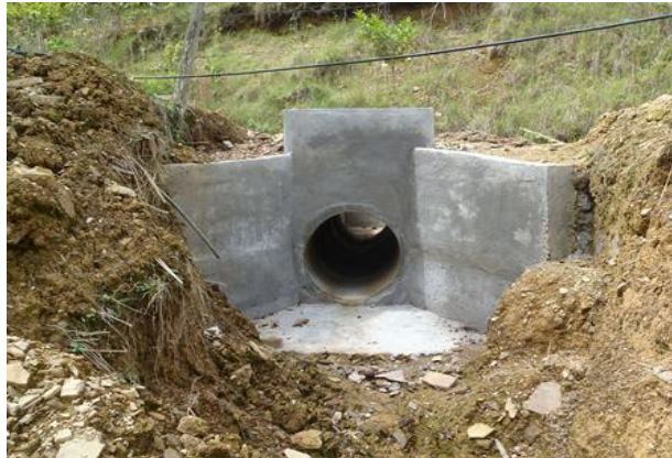
Foto 26.Cabeza de salida Alcantarilla Versalles
