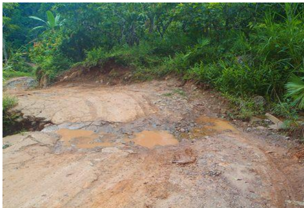
Foto.15 Estado inicial de la obra
