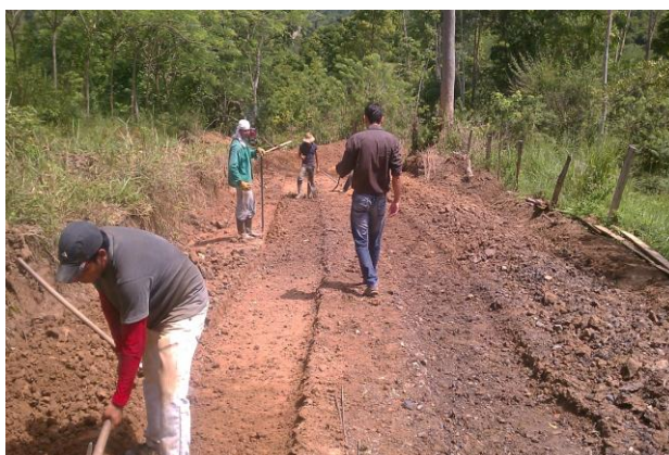
Foto.10 Excavaciones para huellas
