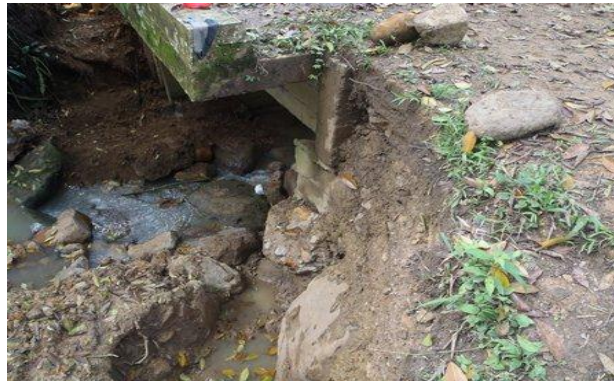
Foto 31. Excavaciones para aletones (Puenton Palo tigre)
