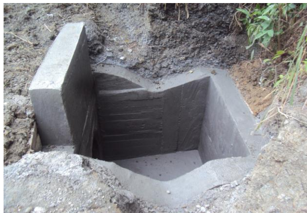
Foto.25 Estado final de la obra, cabeza de entrada de la alcantarilla
