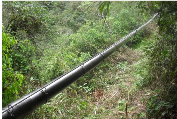
Foto 4. Instalación de aéreos
