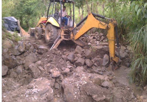
Foto.41 Demolición de alcantarilla existente con retroexcavadora
