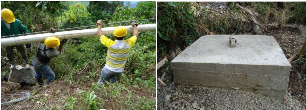
Foto 5. Instalación y anclaje de aéreos
