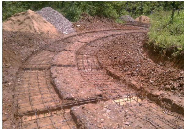
Foto.11 Armado de refuerzo de huellas
