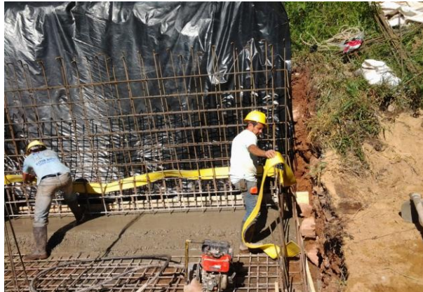
Foto 7. Detalle del refuerzo tanque de almacenamiento 40.000 lts
