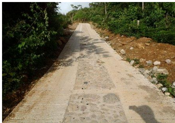
Foto.13 Estado final de la obra
