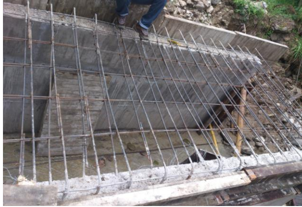
Foto.43 Armado de Refuerzo del box couvert
