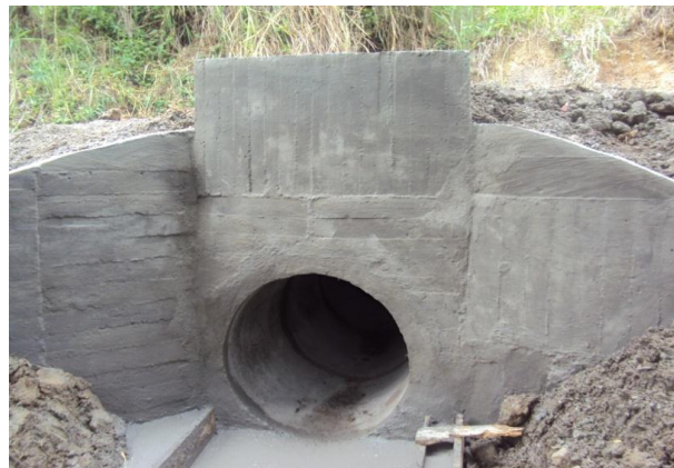
Foto.80 Descole de la alcantarilla La unión
