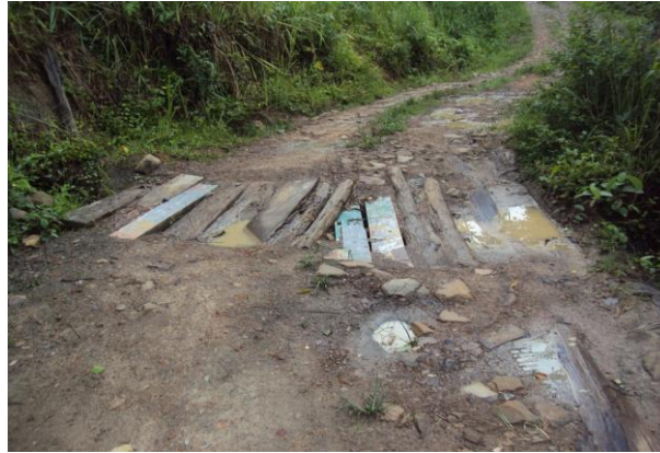
Foto.18 Estado inicial de la obra
