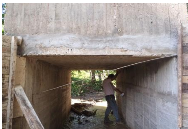
Foto.48 Medición de las dimensiones del box coulvert
