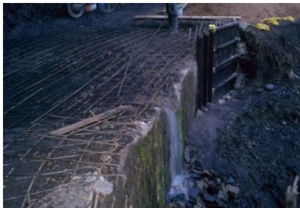
Foto 17. Muro y descole de agua.
