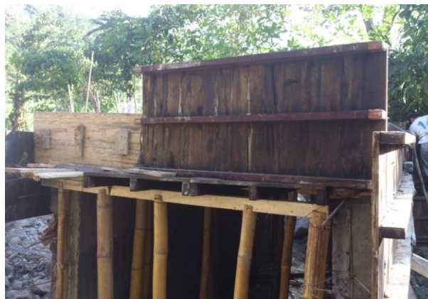
Foto. 46 Formaleta en madera (box culvert)
