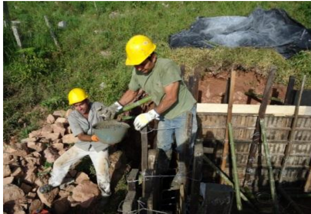
Foto 9.Construcción tanque de almacenamiento 40.000 LTS
