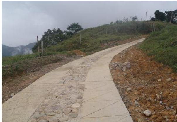
Foto.14 Estado final de la obra
