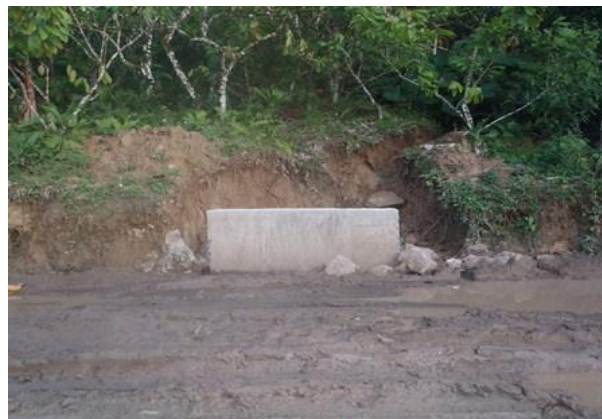
Foto.27 Cabeza de entrada de alcantarilla
