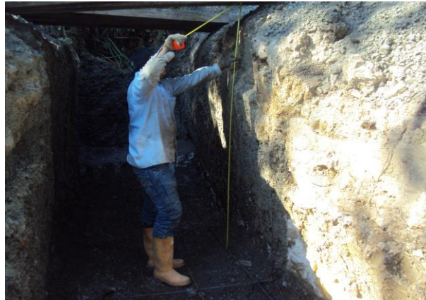
Foto 20. Medición de la excavación
