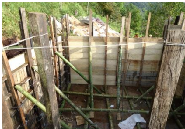
Foto 8. Construcción tanque de almacenamiento 40.000 LTS
