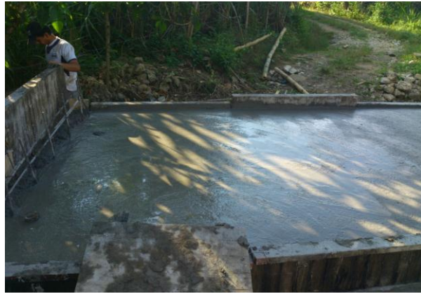
Foto.45 Fundida de box culvert
