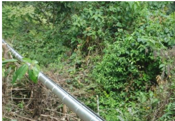
Foto 2. Instalación de Aéreos
