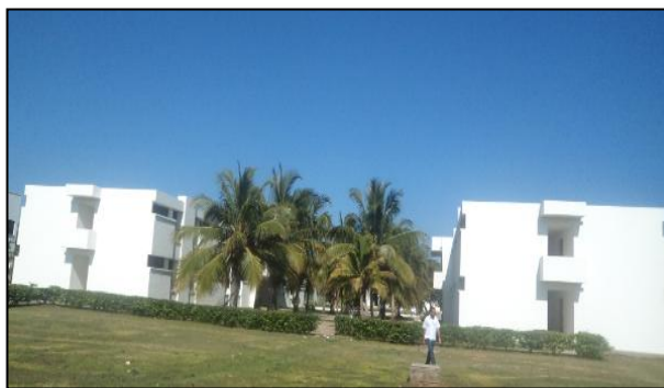
Imagen 1. Registro Fotográfico Edificio Froyland
