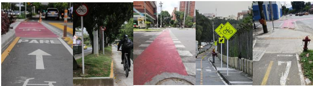
Imagen 24. Demarcaciones con pintura, avisos reflectivos, señalización paso de bicicletas, peatones, de disminución de velocidad, pare y semaforización.
