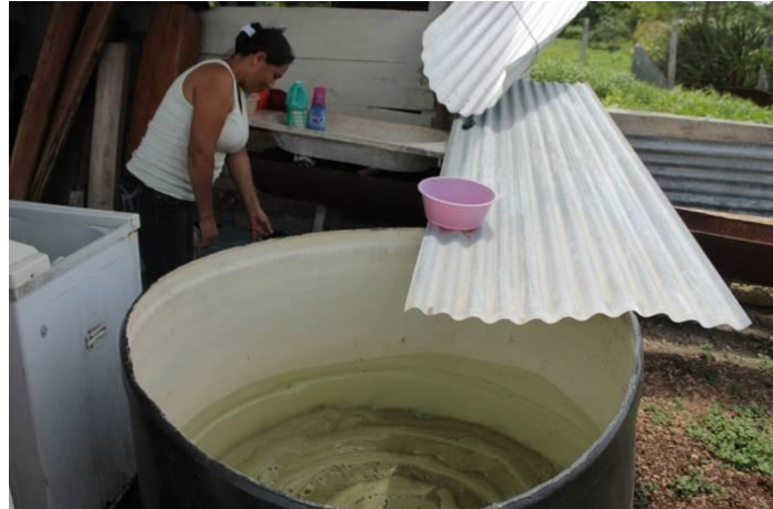
Imagen 7: Adecuación productiva para la recolección y almacenamiento de aguas lluvias
