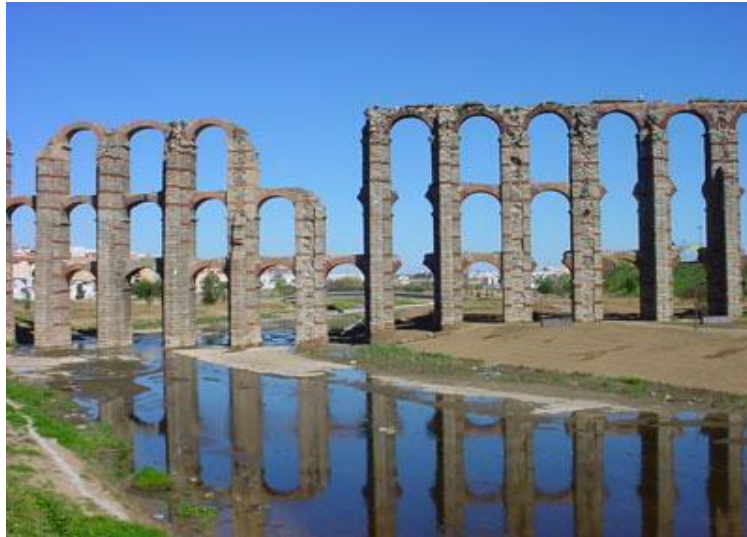
Acueducto Romano “los Milagros” - Fuente: http://historiadelarte.bligoo.es/content/view/655023/Construcciones-romanas.html#.V0fOeJF96hc
