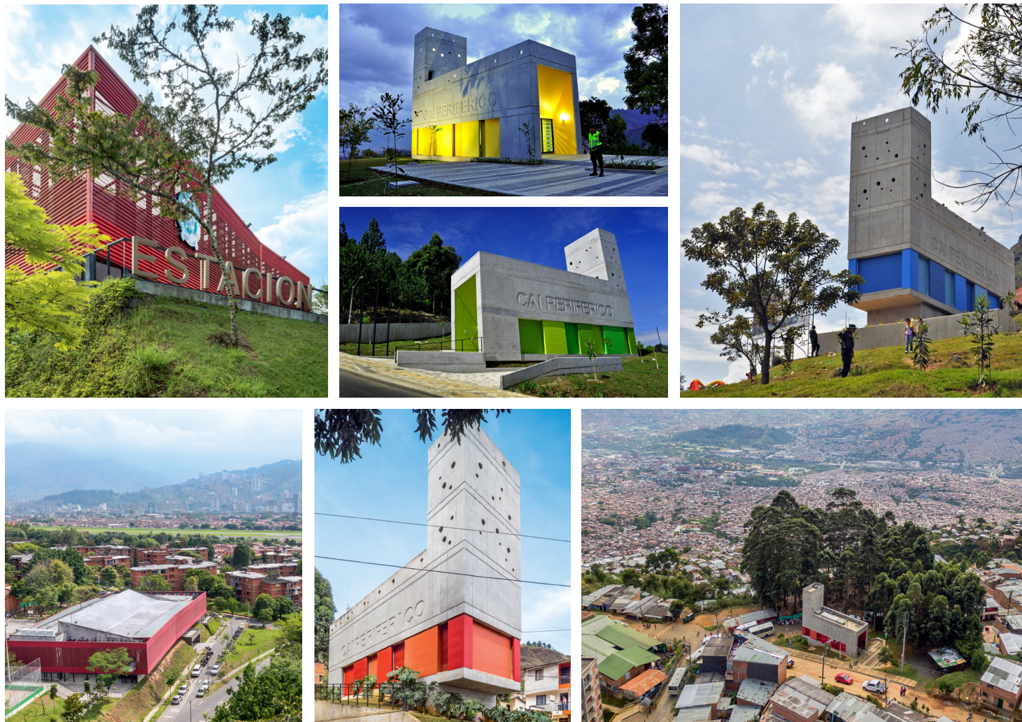
Fig. 28_Edificios EDU: CAI periféricos y estación de policía de Belén. Fotografías. Libro Arquitectura pública e innovación social . Web EDU
