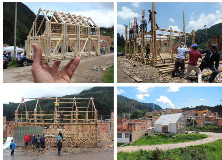
Fig. 35_Casa de la Iluvia. Proceso constructivo. Web Arquitectura Expandida
