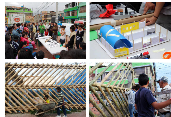
Fig. 30_Espacio comunitario El Trébol. Proceso de construcción. Web Arquitectura Expandida
