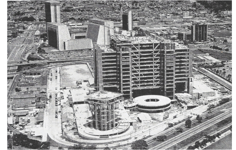
Fig. 06_Edificio EPM. Fotografía en construcción. Revista Escala No. 167
