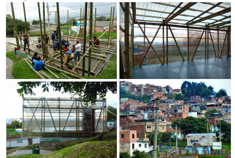
Fig. 33_Casa del viento. Proceso constructivo. Web Arquitectura Expandida
