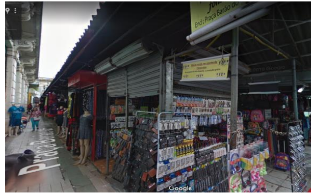
Figura 30 - Situación actual de la Plaza, donde se nota la estructura permanente construida.
