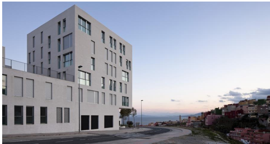
Imagen 8: Edificio contruido. Tomada de: Internacional design.
