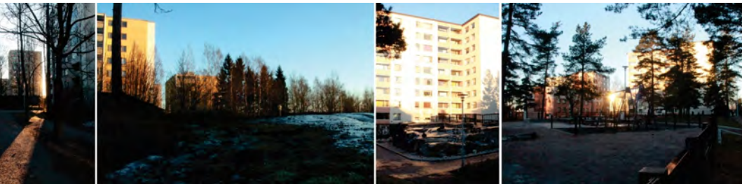
Figura 10. Espacios públicos (patios continuos) en la Ciudad Satélite de Hakunila. Trazada por Eduardo Arango al servicio del despacho de Pentti Ahola (1967-69).
