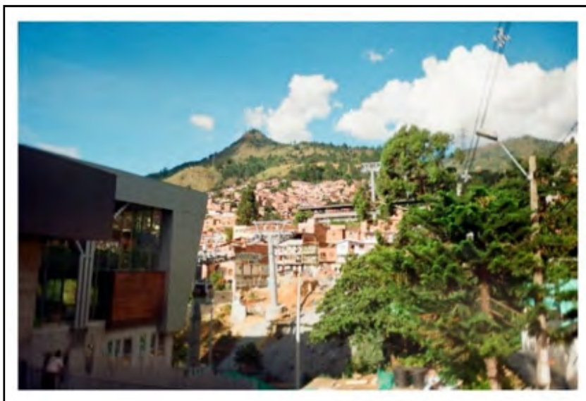
Figura 11. Fotografía 3: Estación del cable (canastas).
