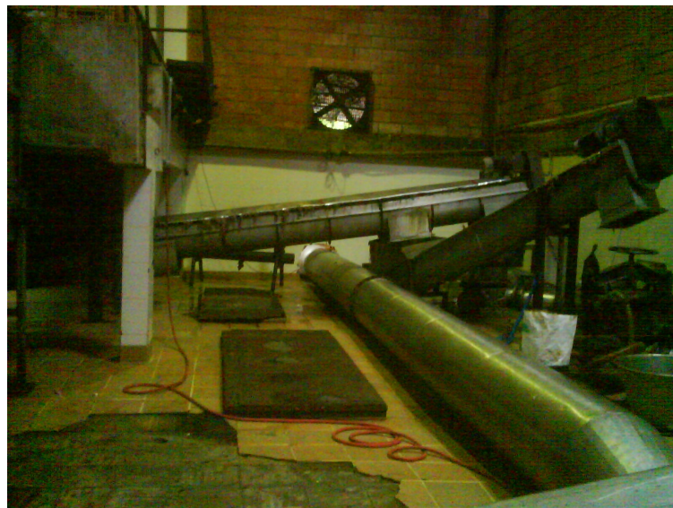
Figura 11. Tuberías de inyección y liberación de vapor (cortesía Avidesa Mac Pollo 2008)
