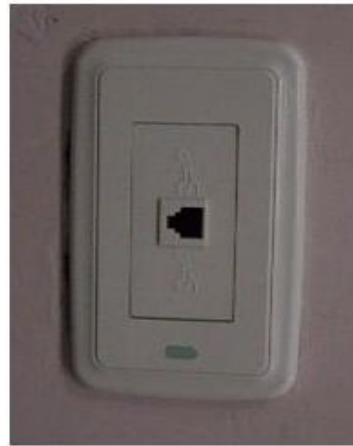
b. Toma telefónico-conector RJ11
