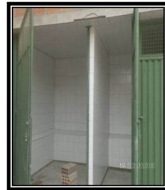
Figura 29. Adecuación cuarto de aseo
