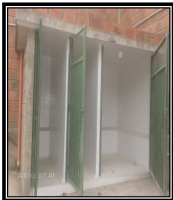
Figura 30. Adecuación cuarto de aseo
