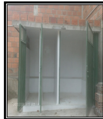
Figura 31. Adecuación cuarto de aseo
