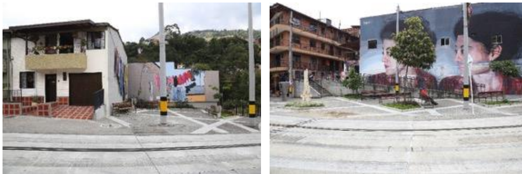
Figura 91: Espacios públicos propuestos en el costado sur occidental de la estación Alejandro Echavarría resultado de la ampliación de la sección vial. Elaboración propia.
