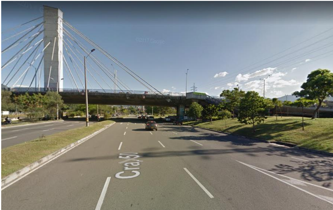
Figura 19. Puente de la Calle 4 sur en la ruta Circular Sur 302 [60].
