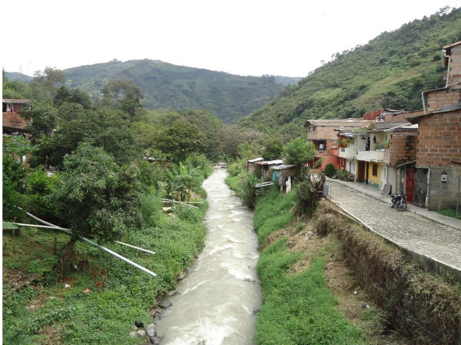
Foto 17. Construcción en zona de retiro de la quebrada
