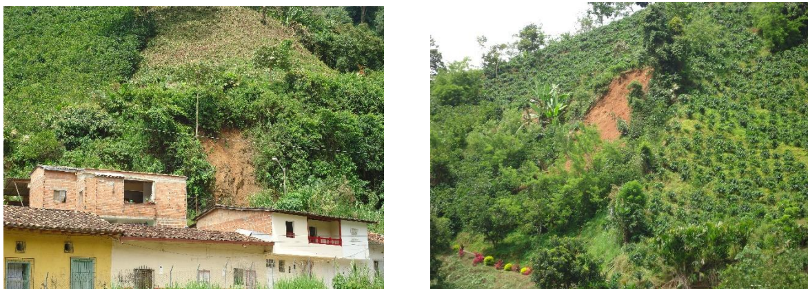
Foto 9 y 10. Ladera con tramos sin cobertura vegetal.
