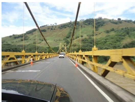
Foto 3. Puente sobre el río Cauca en Bolombolo.
