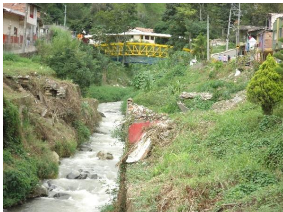
Foto 19. Cimientos de casas construidas al borde de la quebrada.
