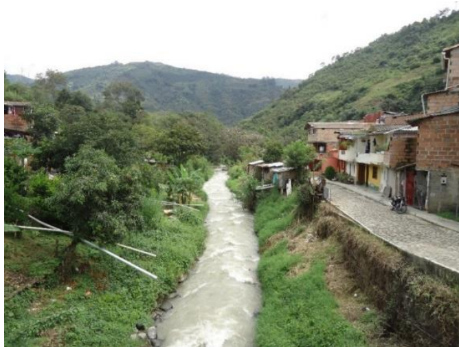
Foto 18. Casas al borde de la quebrada
