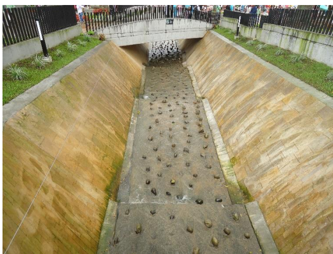
Foto 16. Quebrada canalizada por el centro del parque principal
