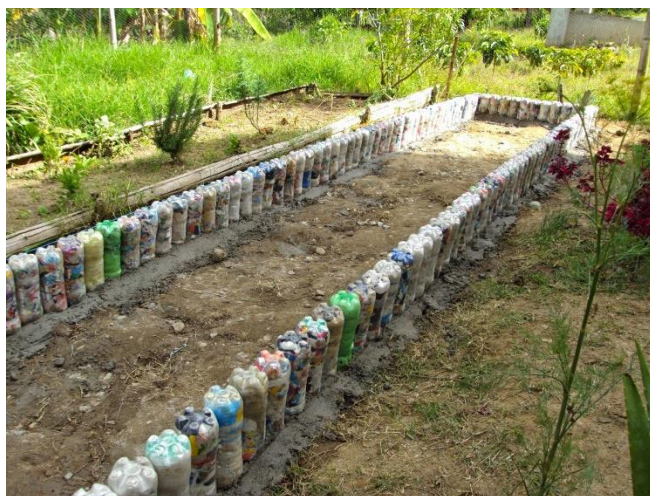
Figura 10 Delimitación huerta con eco-ladrillos.
