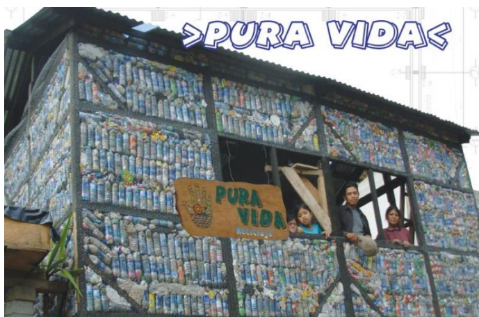
Figura 9 Casa en eco-ladrillos
