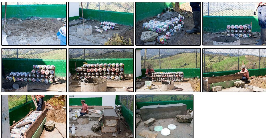
Figura 33 Proceso de construcción de banca con eco-ladrillos.
