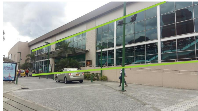
Imagen. 13 Acceso almacén Jumbo las Vegas
