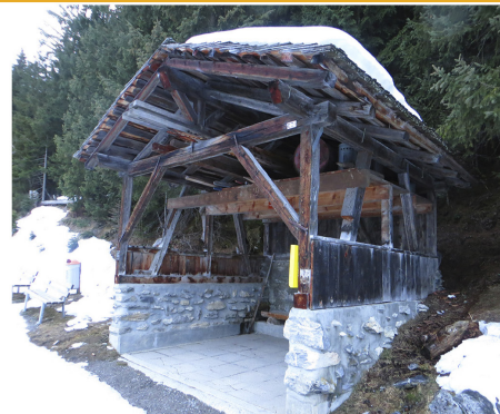
Esqueleto de la estructura de un chalet. Vigas de madera
