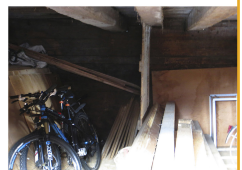
Interior de un chalet tipo almacén.
