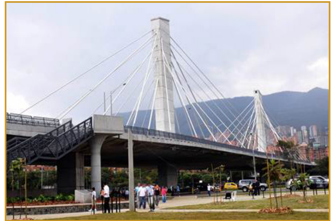
FIG 136. Estado original del puente/ Original bridge condition
