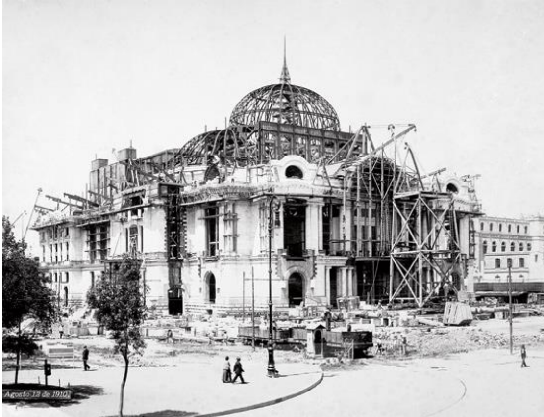
Imagen 7, Construcción del instituto de Bellas Artes, fotografía de 1910. Autor: desconocido
