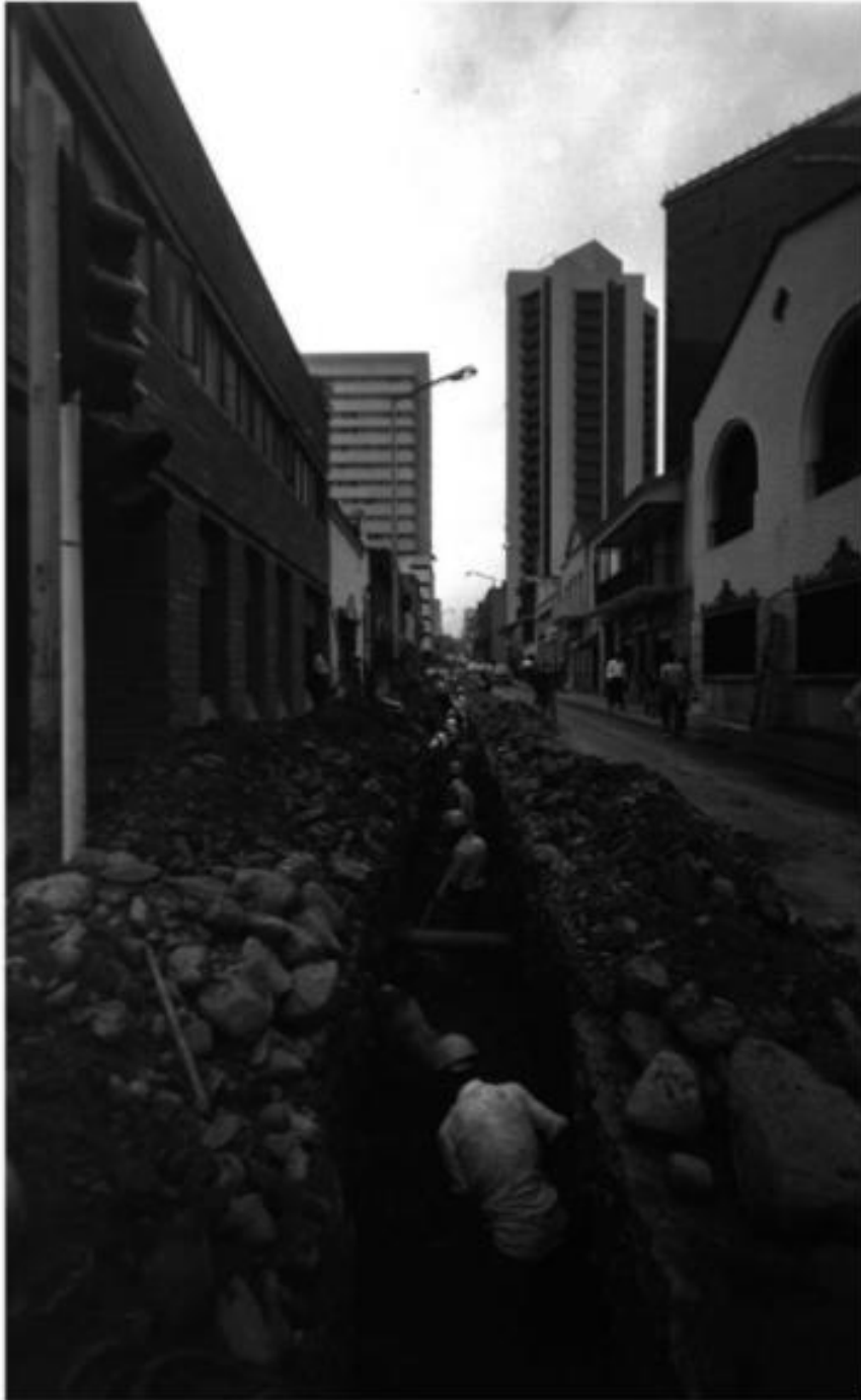
Imagen 5, obra de acondicionamiento del alcantarillado por iniciativa de la junta de acción comunal, fotografía de 1981. Autor: Gabriel Carvajal Pérez
