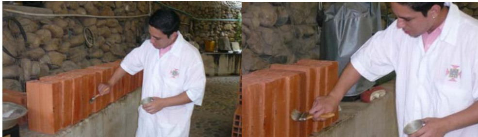
Figura 11. Aplicación Laca a las Unidades de Mampostería.
