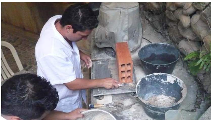
Figura 32. Corte de la Mezcla Sobrante del Borde de la Unidad.
