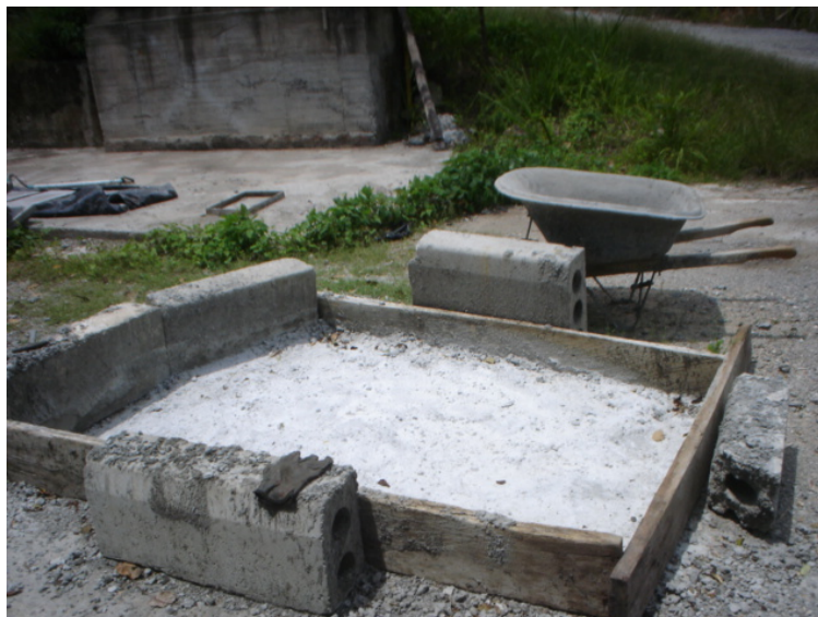
Figura 17. Sitio de Descarga del Material
