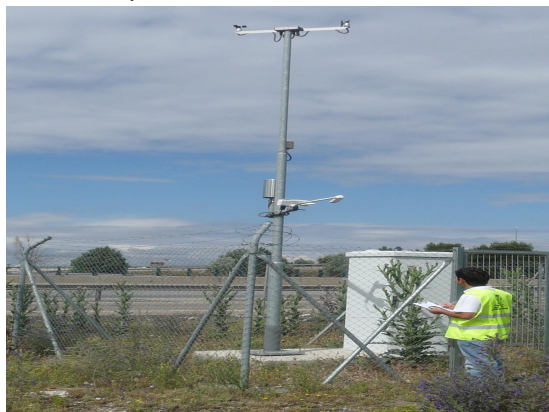
Foto 6. Inspección de estación meteorológica.
